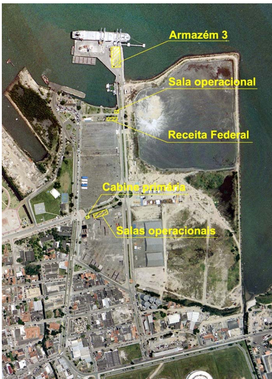
Figura 10-1 : Instalações fixas a serem desmobilizadas, no âmbito da LO atual do Porto de São Sebastião.
