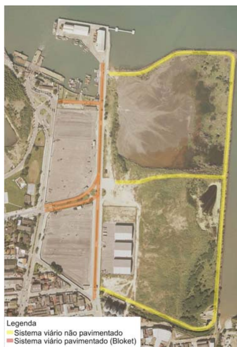
Figura 2.4.3.2 - 1: Sistema Viário Interno.
