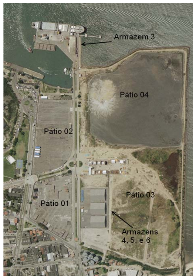
Figura 2.4.3.4 - 1: Instalação de armazenagem
