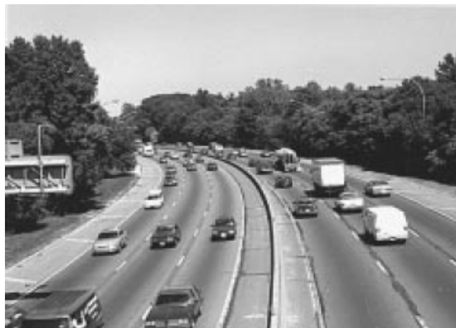
Nível de Serviço D
