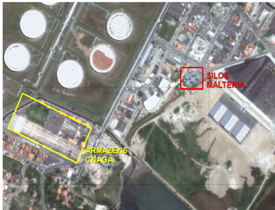
Figura 08. Silos e Armazéns Privados.
