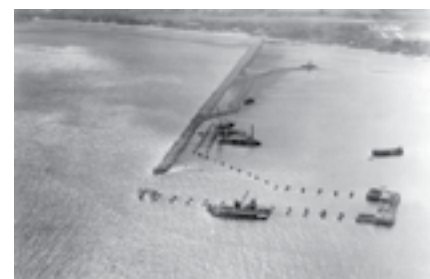
Obras do Projeto Original - 1940
