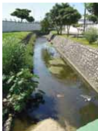
Canal do córrego Mãe Izabel no trecho final, junto à área da Petrobras
