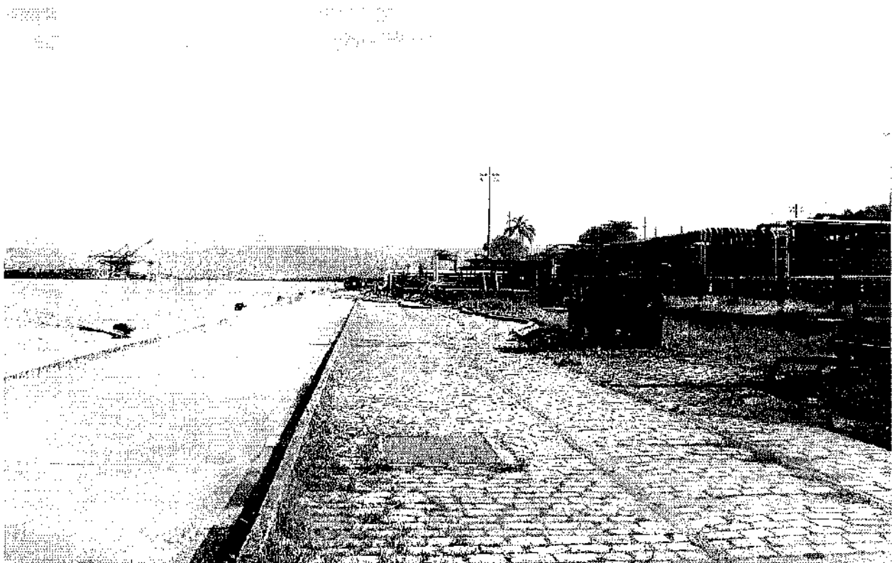
Fig. 8 – Aspecto geral do cais da Ilha Barnabê, com canaleta de drenagem paralelas à margem
