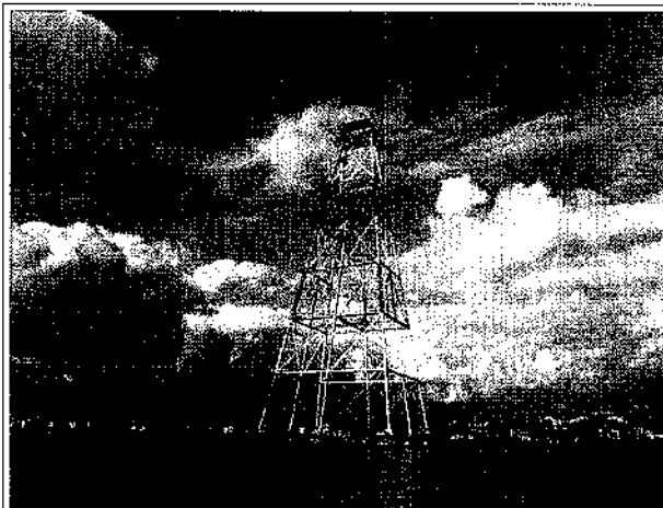
Foto 19 - "Torre grande" da travessia da Linha de Transmissão da UHE Itatinga e comunidade da Prainha (Foto: Nelson Yoneda).
