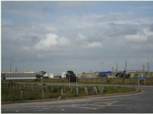
Figura 7.3.1.2.1-286: Usina de Tratamento de Gás de Cacimbas UTGC Petrobrás
