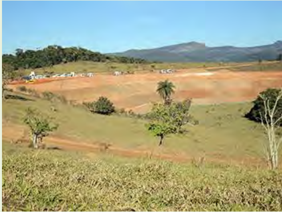
Figura 7.3.1.2.1-4: Canteiro de Obra Mineroduto Minas-Rio.
