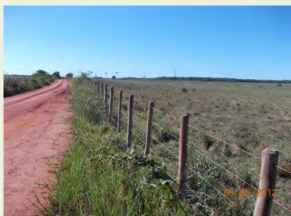
Figura 7.3.10.1-29: Área da LT vista em direção norte, a partir do ponto 15. A LT segue a leste da estrada - lado direito na foto
