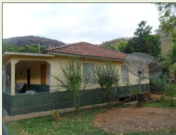
Figura 7.3.1.2.1-172: Casa com antena parabólica.
