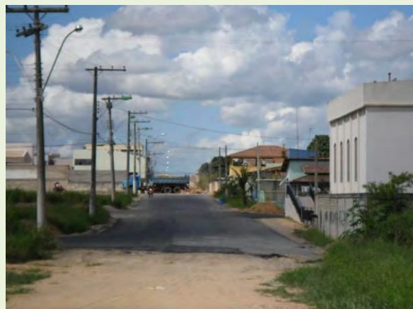
Figura 7.3.1.2.1-246: Rua Principal do Bairro Três Barras
