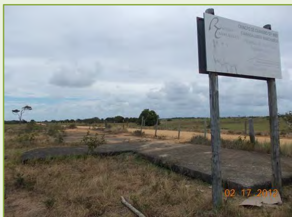
Figura 7.3.10.1-31: Vista do acesso à área do Rancho Tamburello, junto a poço de petróleo desativado na AEL.
