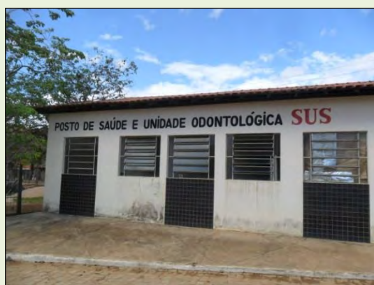
Figura 7.3.1.2.1-169: Fachada do posto de Saúde.
