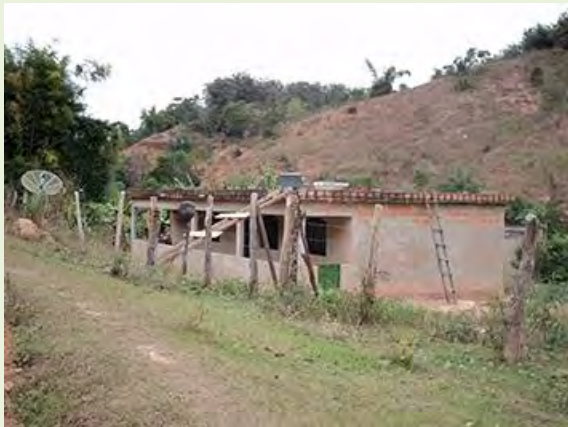
Figura 7.3.1.2.1-39: Casa em construção de pequeno produtor rural
