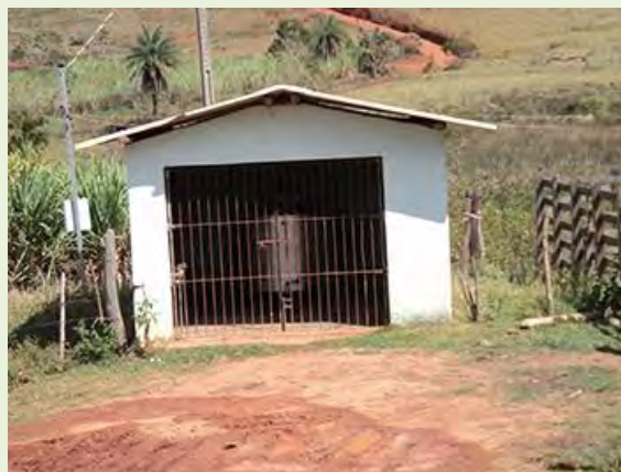
Figura 7.3.1.2.1-23: Refrigerador da Fazenda Ribeirão
