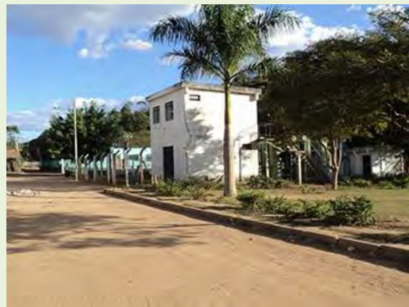
Figura 7.3.1.2.1-99: Estação de tratamento de Esgoto, Pedra Corrida
