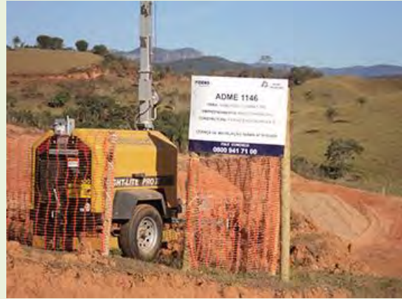
Figuras 7.3.1.2.1-5: Canteiro de Obra Mineroduto Minas-Rio.
