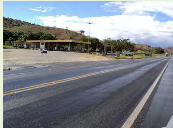
Figura 7.3.1.2.1-117: Posto Shell no entroncamento com a BR-116.
