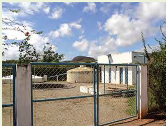
Figura 7.3.1.2.1-126: Estação de tratamento de esgoto, Bairro São José.
