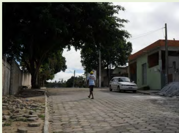
Figura 7.3.1.2.1-269: Rua de Bloquete no Bairro Santa Cruz
