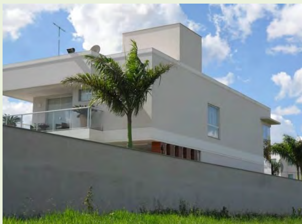
Figura 7.3.1.2.1-245: Casa no Bairro Três Barras
