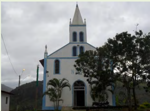
Figura 7.3.1.2.1-225: Igreja de Nossa Senhora do Bom Parto
