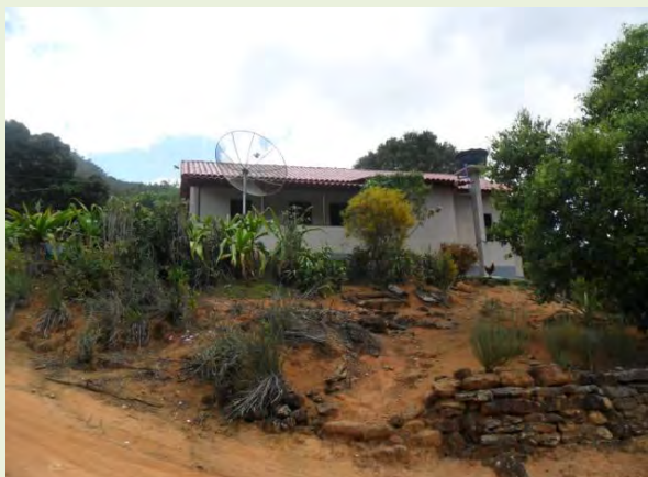
Figura 7.3.1.2.1-213: Residência de alvenaria - Córrego Novo
