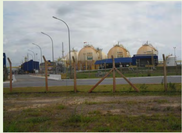
Figura 7.3.1.2.1-287: Usina de Tratamento de Gás de Cacimbas UTGC Petrobrás
