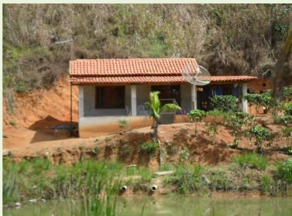
Figura 7.3.1.2.1-197: Residência no Córrego da Alegria
