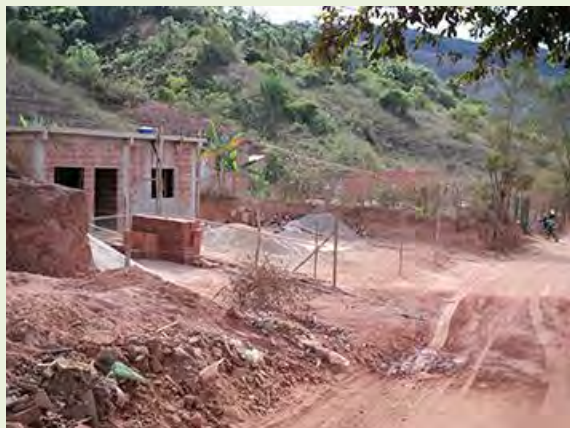
Figura 7.3.1.2.1-63: Novas construções no Baixadão.
