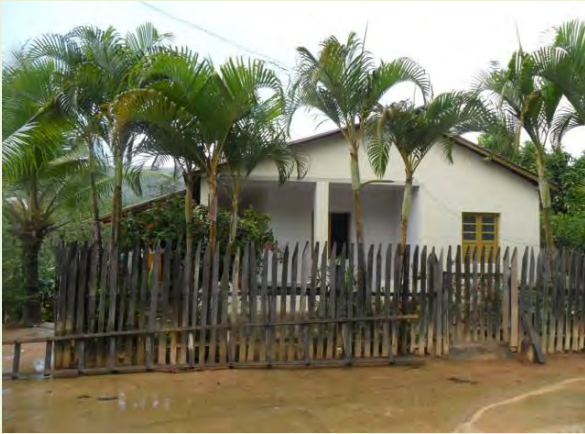
Figura 7.3.1.2.1-199: Residência de alvenaria - Pirangi
