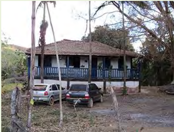
Figura 7.3.1.2.1-92: Sede da Fazenda Descanso, arrendada para utilização de pasto
