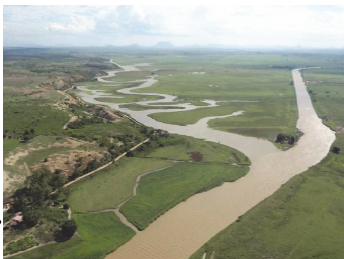
Vista de canal e de parte do Rio Itabapoana nas proximidades de sua foz e do local previsto para implantação do Porto Central
