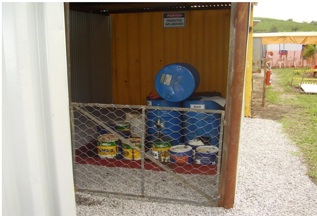
Figura 1.3-49 - Unidade para armazenamento temporário de Resíduos Classe I
