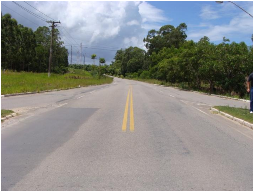
Figura 1.3-28– Sentido Vitória Aracruz baixo volume, fluxo livre e sem presença de comboios. Característica de nível de serviço A
