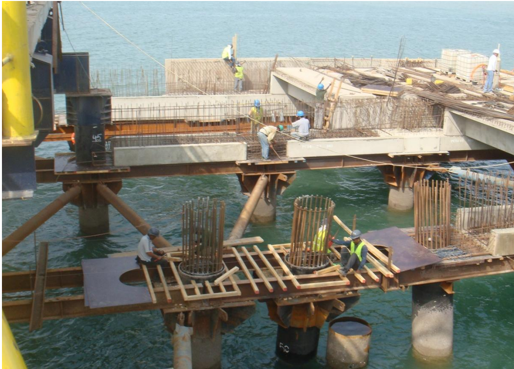
Figura 1.3-11 – Exemplo de montagem das vigas longitudinais
