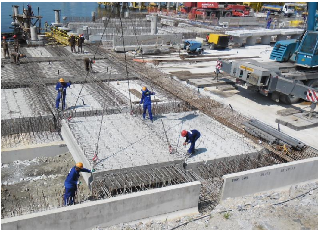
Figura 1.3-12 – Exemplo de montagem das lajes
