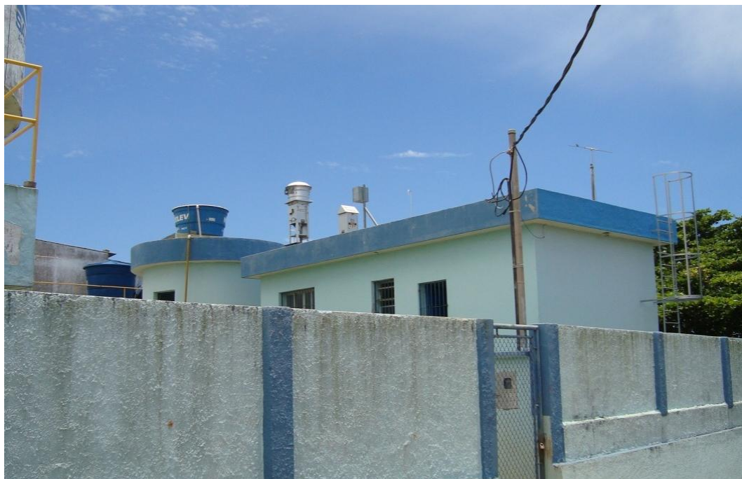
Figura 4.1-42 - Estação de Monitoramento – Unidade Barra do Sahy
