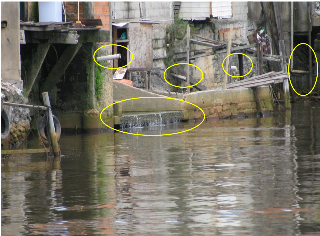
Figura 4.1-60 – Situação crítica de lançamento de esgoto doméstico no estuário do rio Riacho
