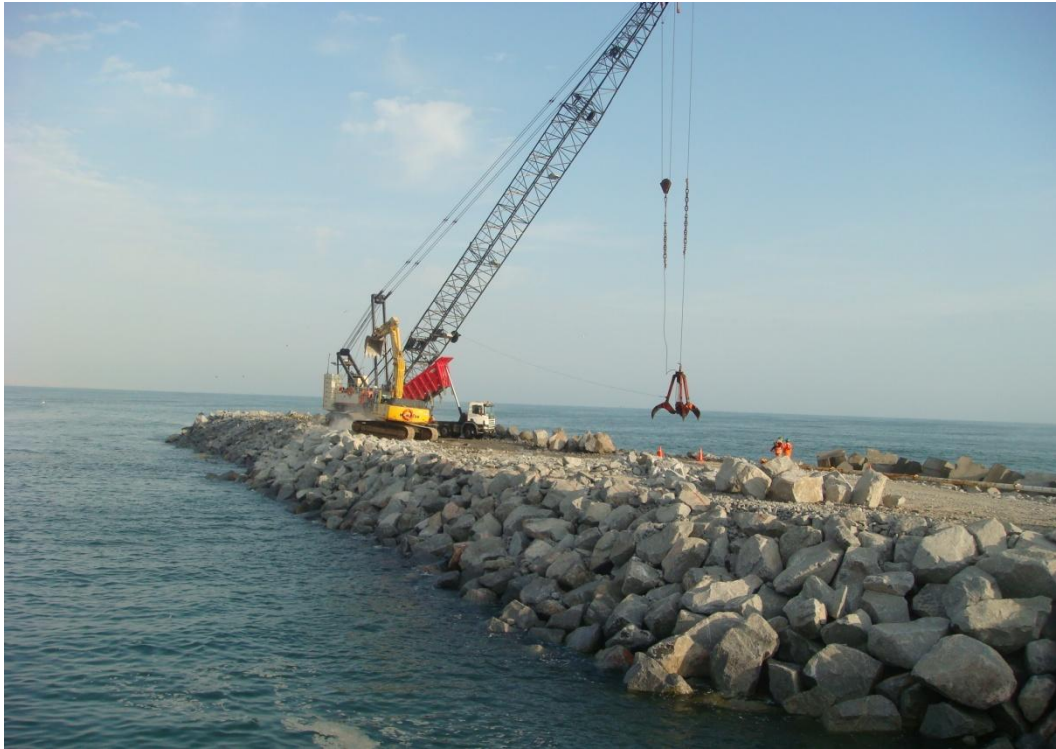
Figura 1.3-7 – Exemplo do processo de construção de quebra mar Fonte: EXE Engenharia
