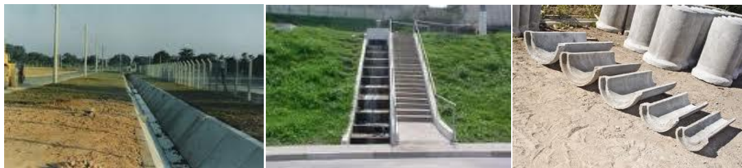
Figura 1.3-42 Vista típica de sistema de drenagem de águas pluviais
