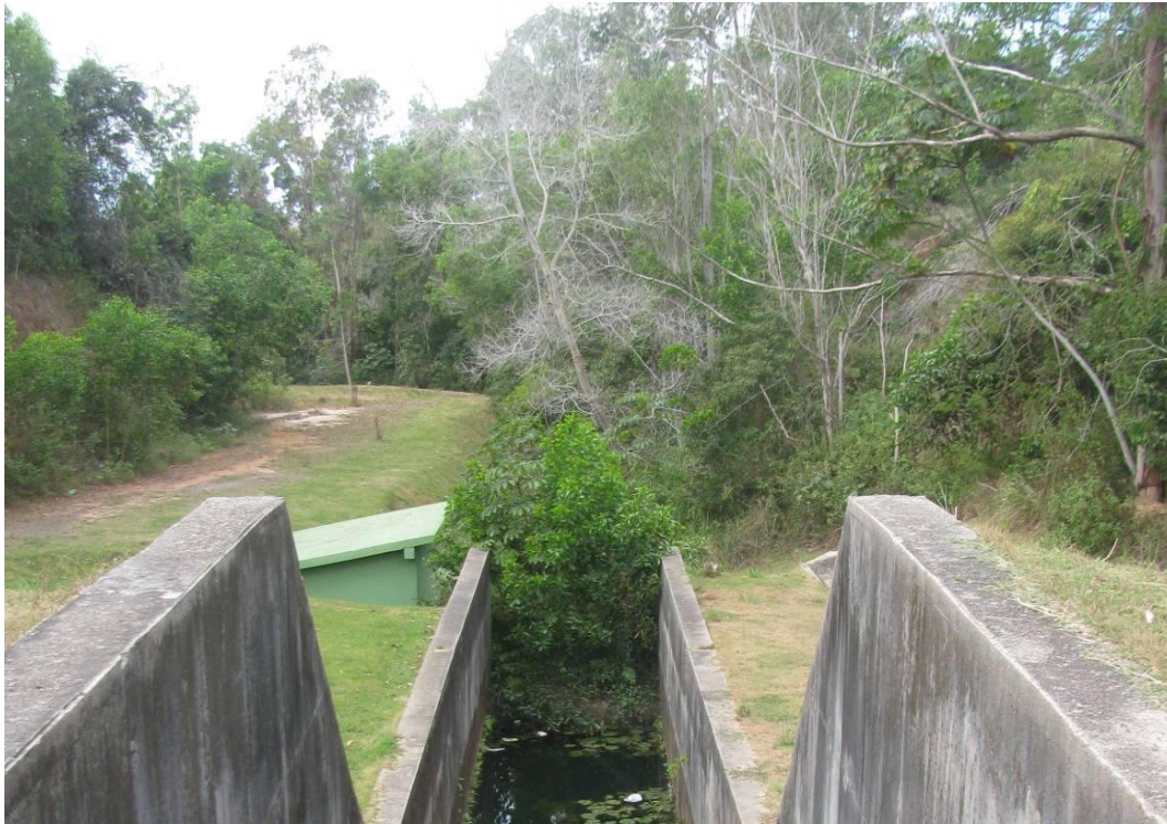
Figura 4.2-43 – Canal de drenagem da barragem no ponto 3
