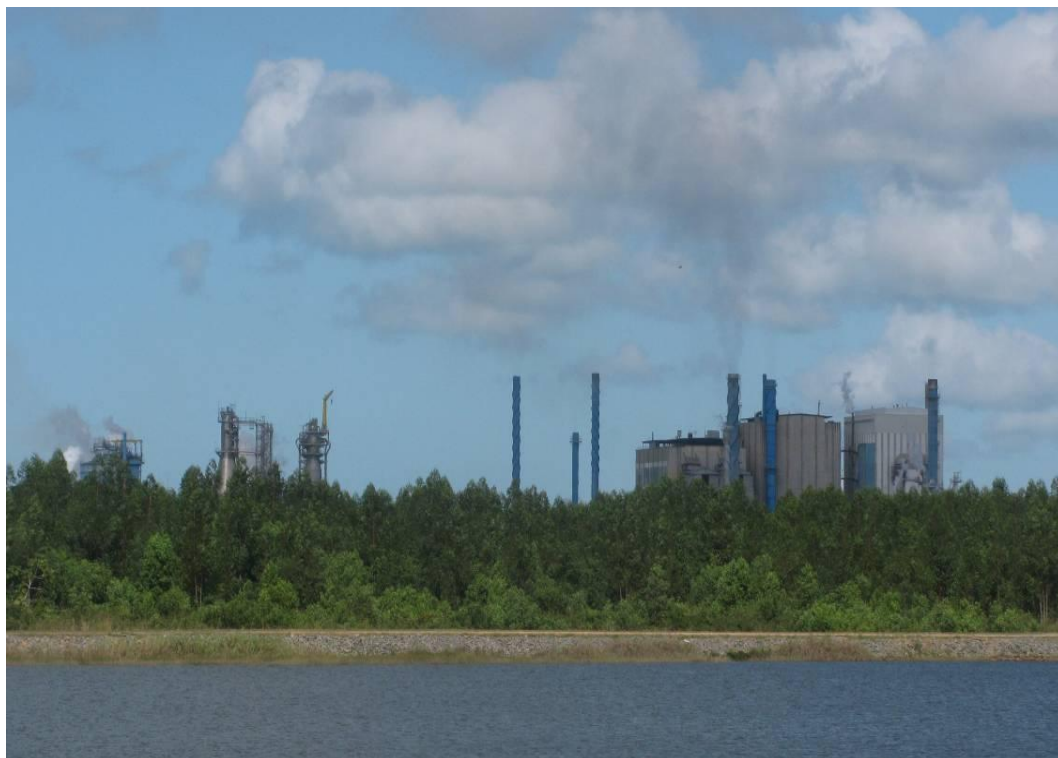
Figura 4.2-42 – Barragem no ponto 2
