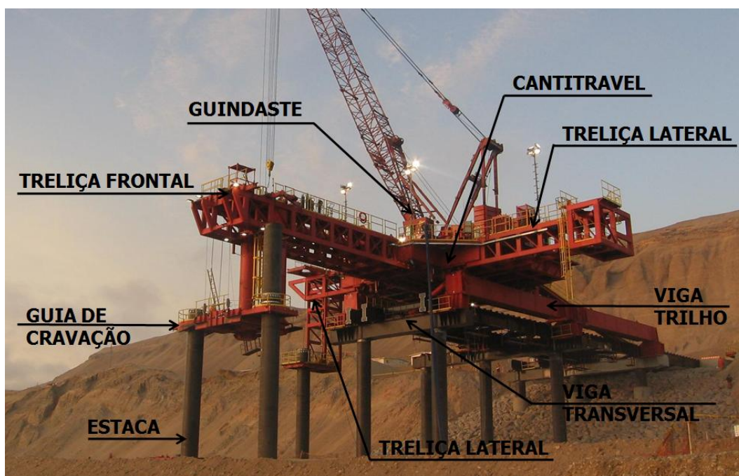
Figura 1.3-13 – Sistema cantitravel e equipamentos de apoio
