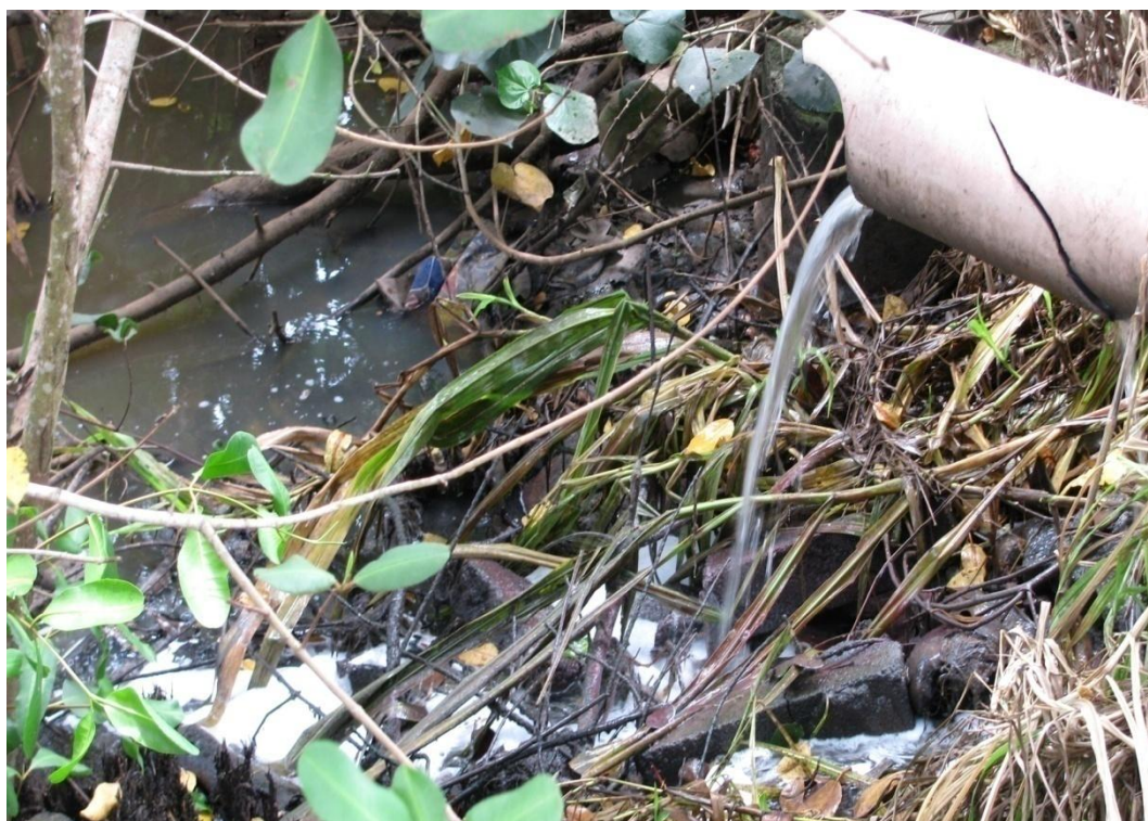
Figura 4.1-58 – Ponto de Lançamento de esgoto doméstico no estuário do rio Riacho
