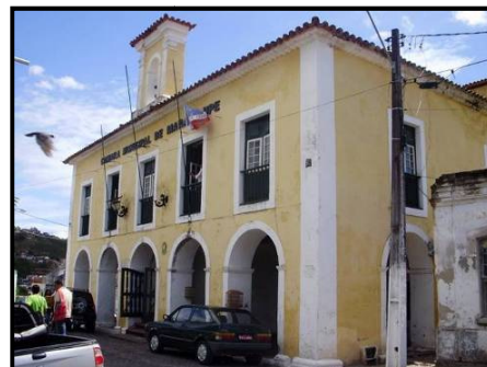
FIGURA 73 – Paço Municipal, atualmente casa da Câmara Municipal de Maragogipe.
