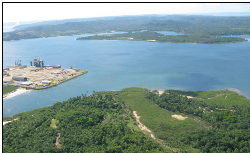
FIGURA 2.3-1 - Área de Implantação do Estaleiro do Paraguaçu.
