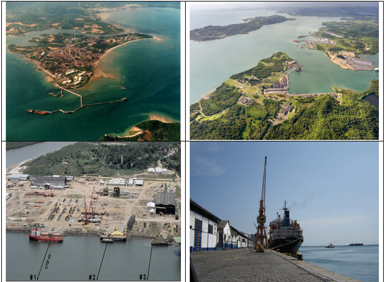
FIGURA 2.1- 1 – Instalações portuárias e estaleiro na BTS. Da figura no lado esquerdo superior girando no sentido horário: Terminal Marítimo de Madre de Deus (TEMADRE); Base Naval, Porto de Aratu e Terminal da Ford na Baía de Aratu; Canteiro de São Roque do Paraguaçu e Porto de Salvador.
