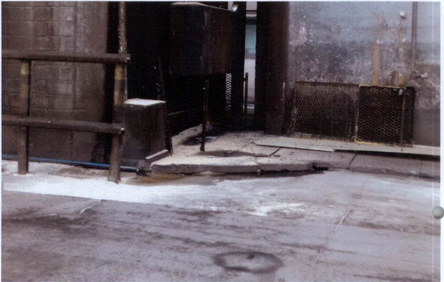
Figura 18: Locais com acúmulo de resíduos, inacessíveis aos carrinhos de varrição.
