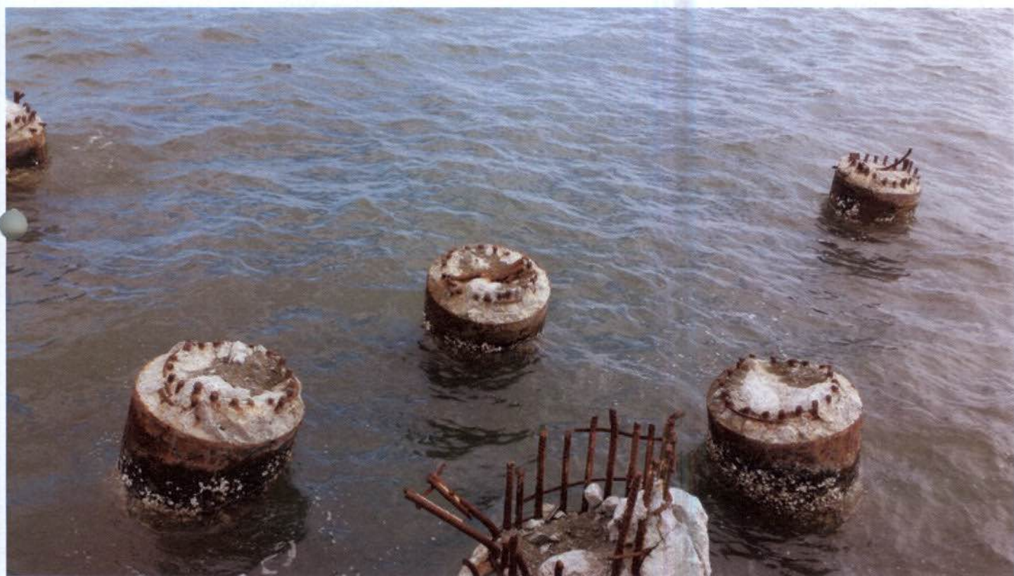
Figura 33: Permanência da fundação de dolphin antigo
