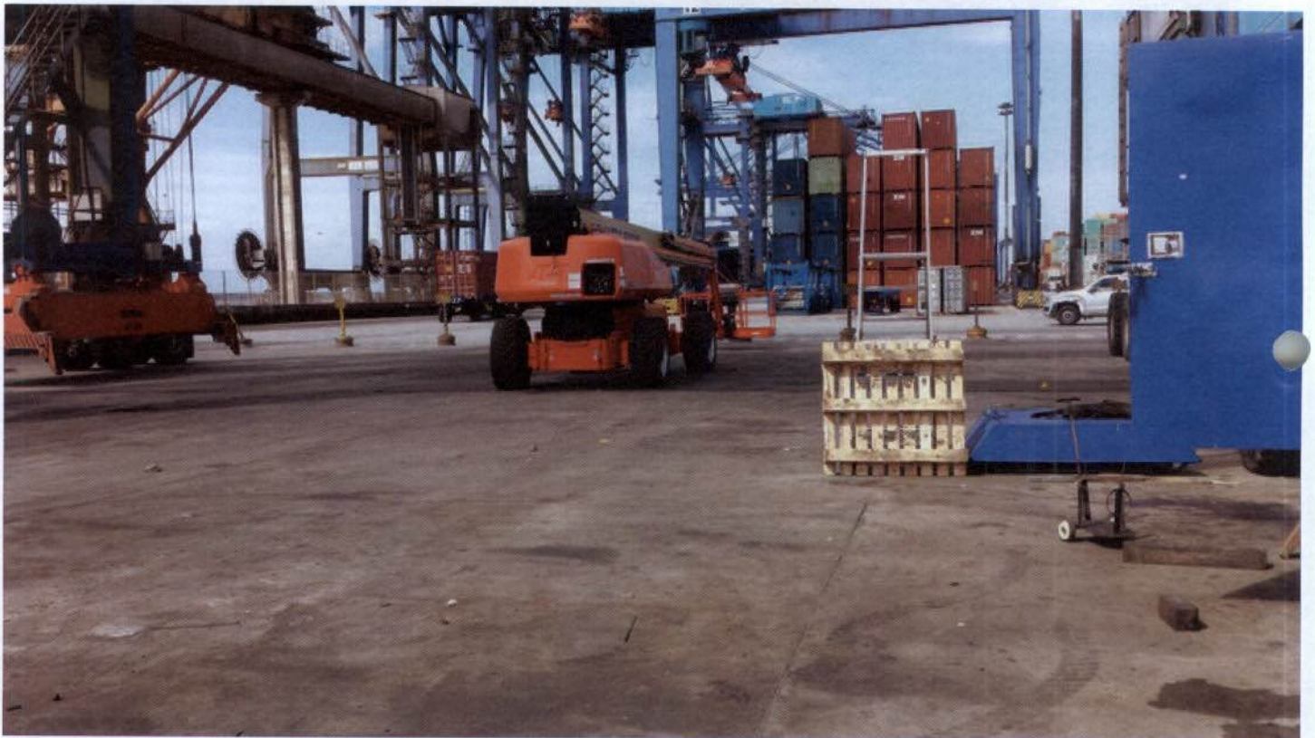
Figura 39: Piso impregnado com óleo.
