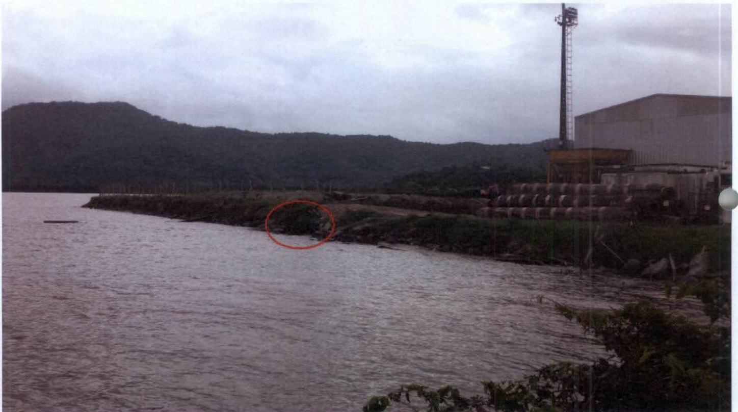
Figura 11: Saída de drenagem pluvial da área de aterro.
