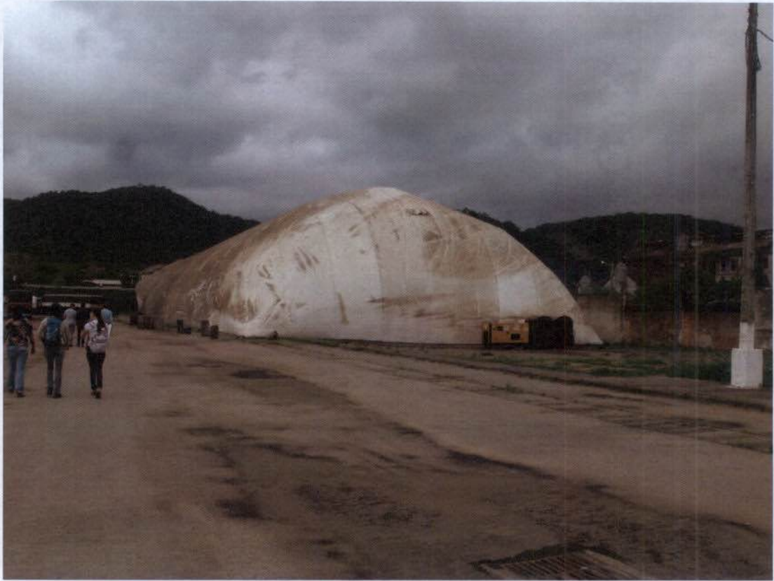
Figura 6: silo inflável de fertilizantes licenciado pelo IAP .
