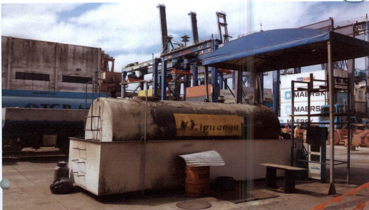
Figura 36: Tanque de armazenamento de óleo.
