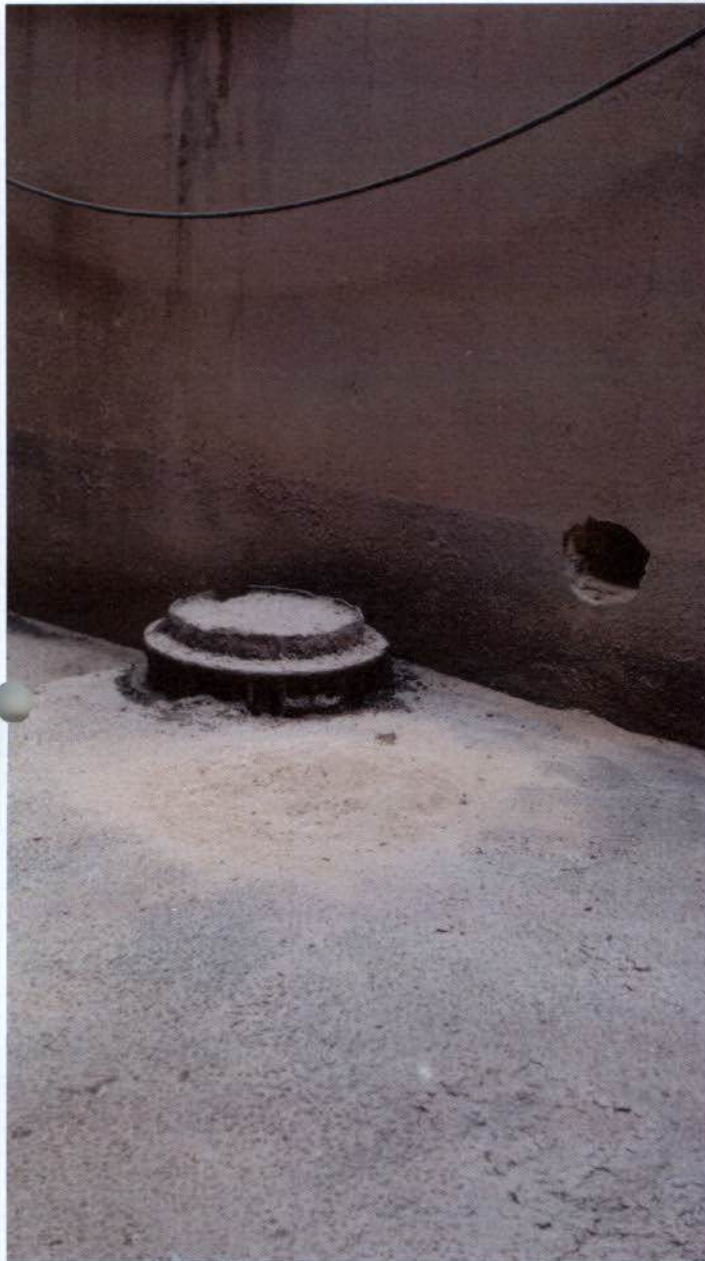
Figura 24: Parte mais antiga do porto onde observa-se acúmulo de resíduos de granéis sólidos.
