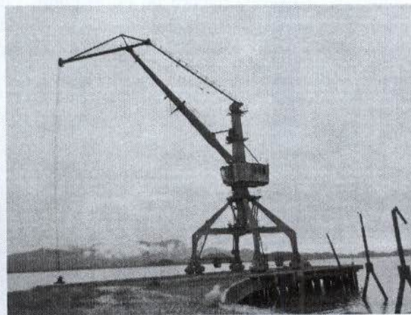
Figura 10 - Guindaste paralisado no cais do Porto de Antonina
