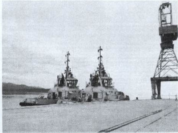
Figura 38 – Vista do cais de atracação do TPPF
