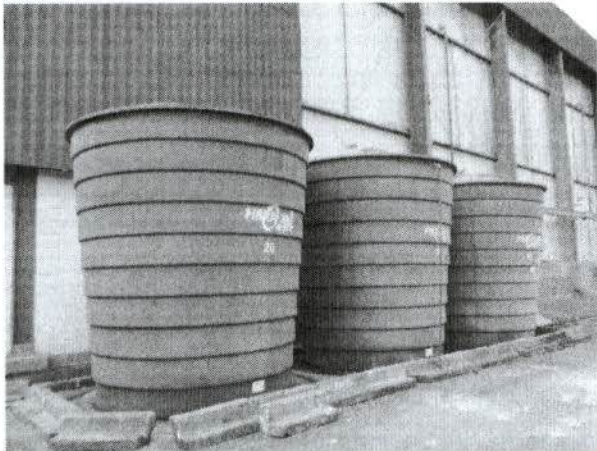
Figura 54 – Tanques de armazenamento de água da chuva
