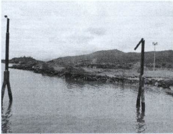
Figura 27 – Área aterrada do porto público de interesse da empresa Techint
