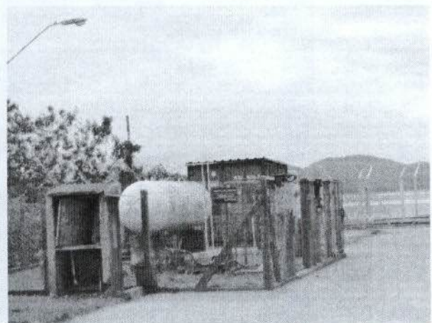
Figura 49 – Tanque de armazenamento de GLP
