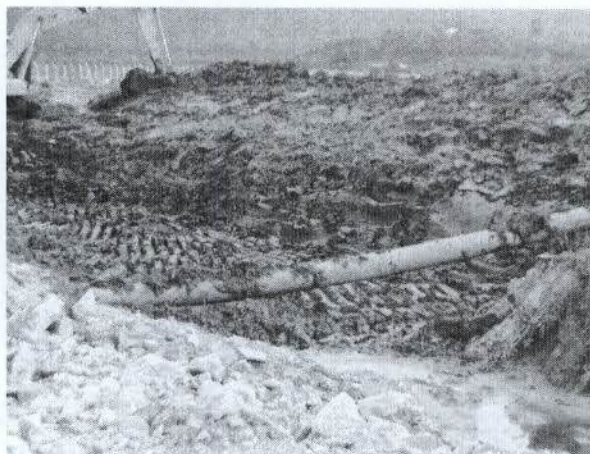
Figura 57 – Obra de construção de estacionamento
