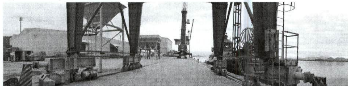
Figura 36 – Vista geral do TPPF
