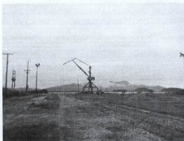
Figura 09 - Guindaste paralisado no cais do Porto de Antonina
