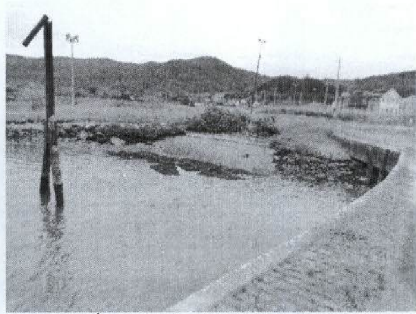
Figura 28 – Área aterrada do porto público de interesse da empresa Techint
