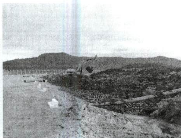
Figura 56 – Obra de construção de estacionamento
