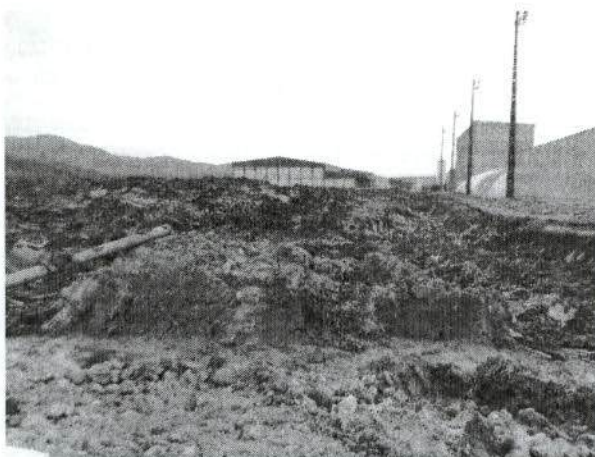
Figura 55 – Obra de construção de estacionamento
