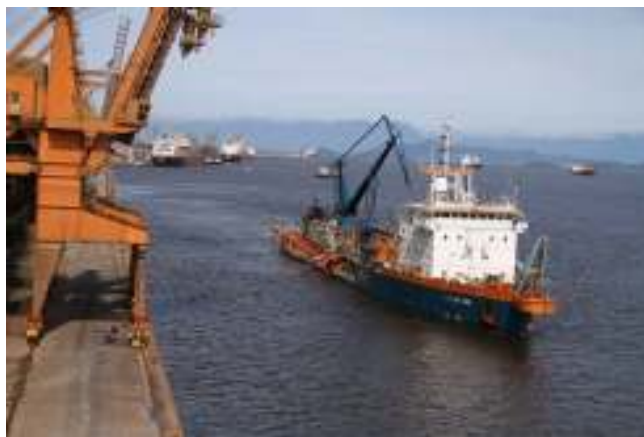
Figura 638. Dragagem HAM 309 em operação na área dos berços de atracação do Porto de Paranaguá, onde não se observa VISUALMENTE a formação de pluma de sedimentos.
