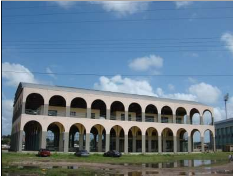
Figura 556. Novo Mercado Municipal de Paranaguá.
