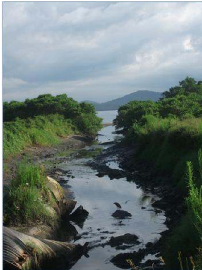
Figura 346. Canal de drenagem visto do terreno.
