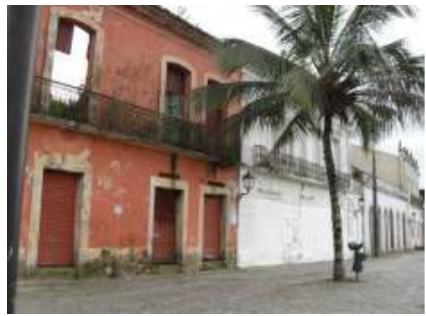
Figura 569. Rua da Praia, atual rua General Carneiro. No detalhe, os prédios antigos de arquitetura colonial e neo-brasileira.
