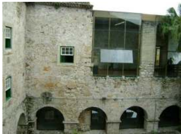
Figura 565. Casario histórico nos arredores do Porto de Paranaguá.
