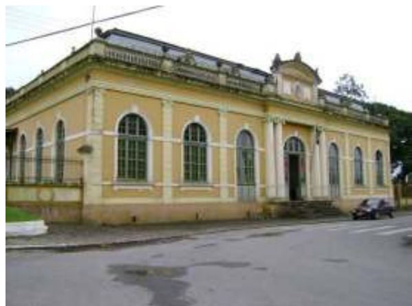
Figura 567. Casario histórico na área de entorno do Porto de Paranaguá
