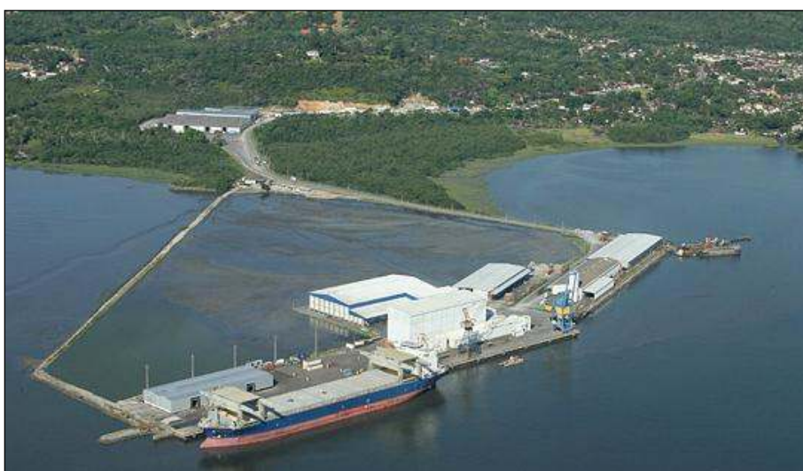
Figura 52. Instalações da empresa Terminais Portuários Ponta do Félix S/A. Fonte: ACQUAPLAN (2010).
