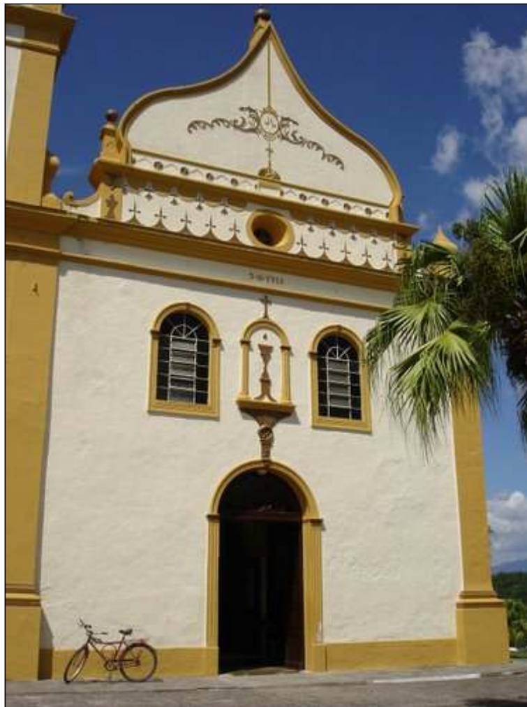
Figura 623. Igreja Nossa Senhora do Pilar.
