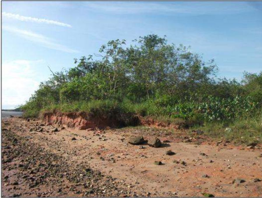
Figura 354. Área de borda sofrendo processo de erosão.
