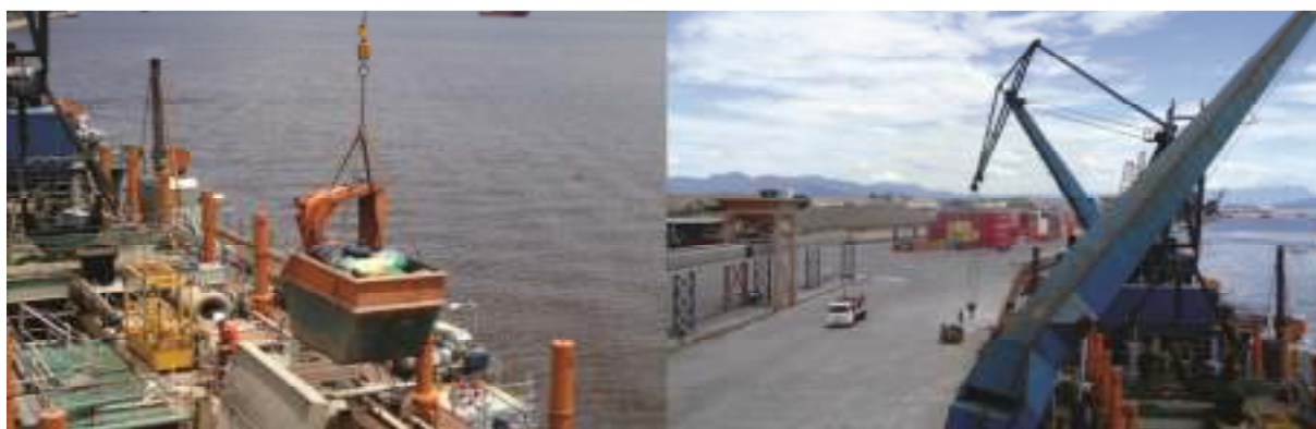
Figura 63. Operação de transbordo de resíduos da draga para o cais do Porto de Paranaguá.
