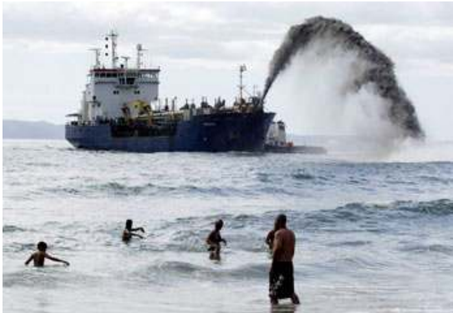
Figura 634. Ilustração de equipamento de dragagem com cisterna e sistema de bombeamento despejando sedimentos na antepraia que serão naturalmente retrabalhados pela dinâmica litorânea.
