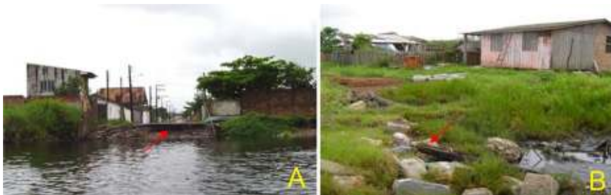
Figura 517. Asfalto sobre o mangue (A) e caliça aterrando o mangue (B). Fonte: Prefeitura Municipal de Paranaguá (2009).
