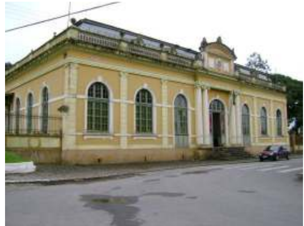
Figura 583. Casario histórico na área de entorno do Porto de Paranaguá
