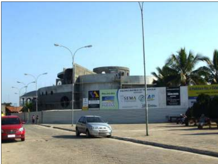
Figura 554. Instalações do Aquário Marinho de Paranaguá em fase de construção.
