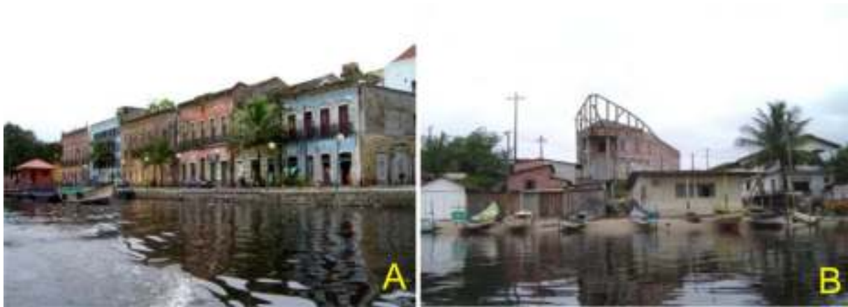
Figura 514. Sobrados históricos (A) e construções Ilha de Valadares (B). Fonte: Prefeitura Municipal de Paranaguá (2009).
