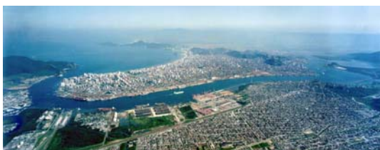
Vista aérea do Porto de Santos e Canal de Acesso
