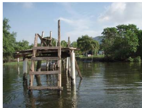
Atracadouro existente na Ilha dos Bagres
