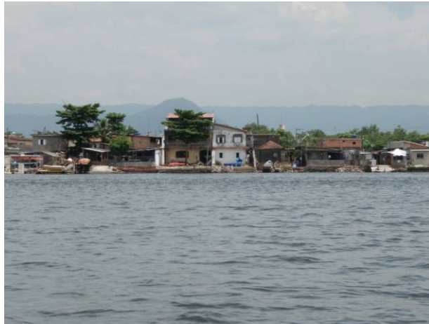
Figura 4.2.3-39 – Vista da Rua Japão.
