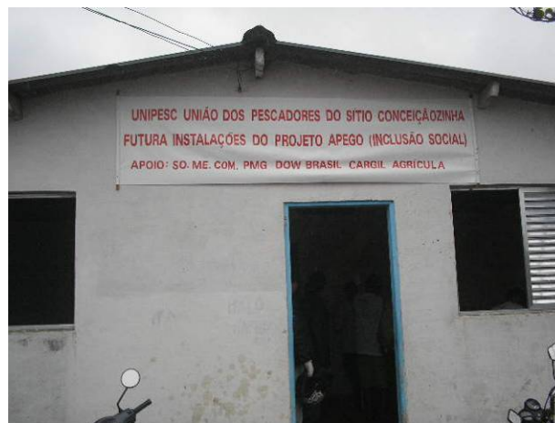
Figura 4.2.3-36 – Instalações da UNIPESC na Conceiçãozinha.
