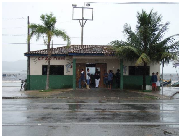
Figura 4.2.3-33 – Vista da Capatazia do Perequê.
