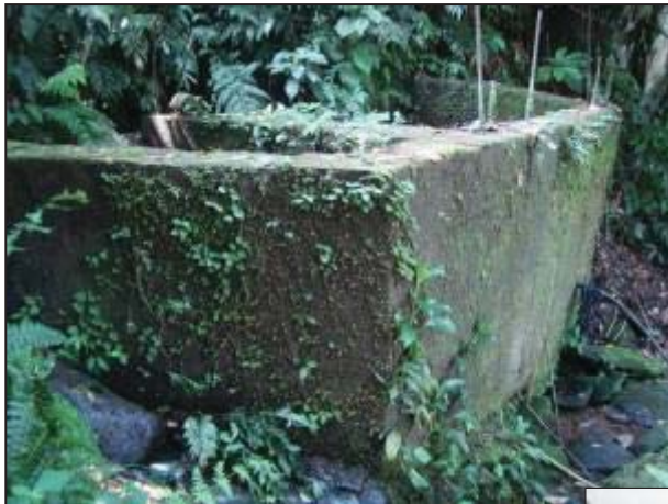
Caixa de água em concreto dentro da propriedade "Triunfo".
