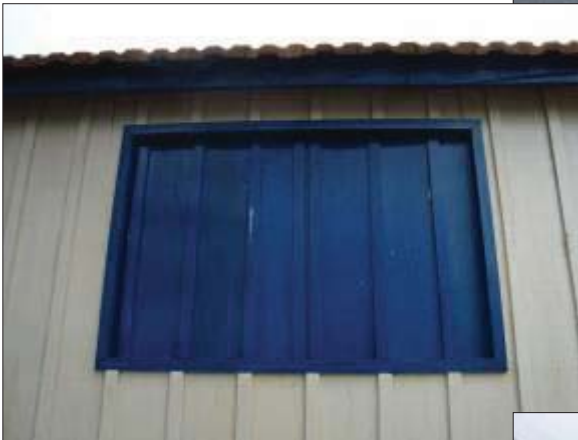
Detalhe de janela e as tábuas de vedação, notar a mata-junta entre as tábuas
