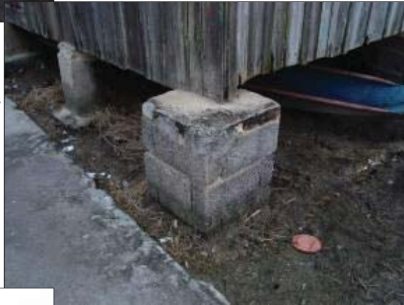
Detalhe dos pilares de alvenaria (Palafita de Ilha Diana)
