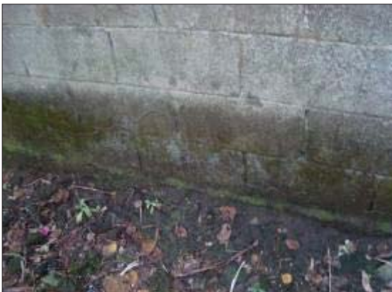
Detalhe do barrado com excesso de umidade (Casa sede) - Sítio (Caseiro – Sr. Osvaldo) - Ilha dos Bagres
