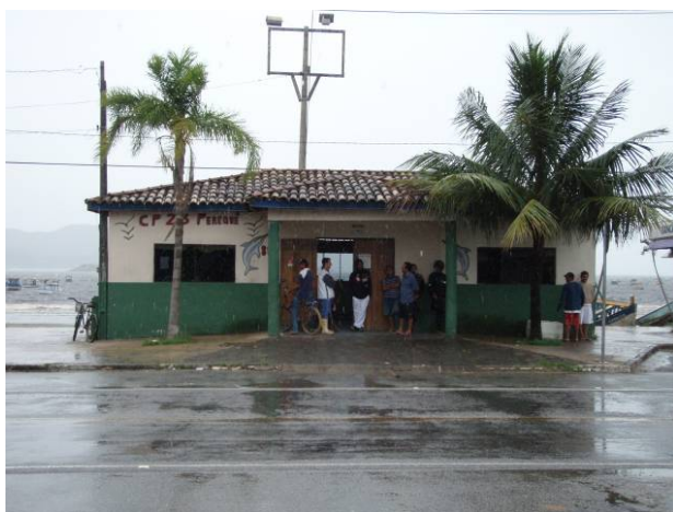
Foto 9.5.3.6-26: Vista da Capatazia da Praia do Perequê
