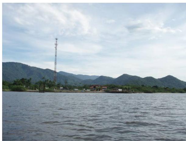
Foto 9.5.3.6-13: Vista de Caruara
