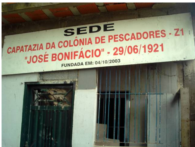
Foto 9.5.3.6-6: Vista da Capatazia da Vila dos Pescadores
