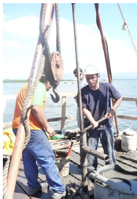
Foto 9.3.9.2-7: Cravação de revestimento e operação de lavagem de amostras de subsuperfície
