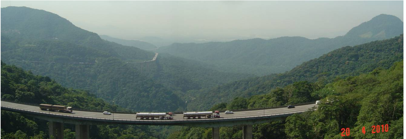
Foto 9.3.5.2-6: Vista geral da Unidade de Padrões e Formas Semelhantes Da52 associada à Escarpa/Serra do Mar e identificada na porção norte-noroeste da All, na região da divisa dos municípios de São Bernardo do Campo, Cubatão e São Vicente. Ao fundo e à direita, vista da Unidade Da51. A Unidade Da52 apresenta escarpas e cristas de topos aguçados e formas de dissecação muito intensas, sujeita aos processos erosivos agressivos inclusive com movimentos de massa associados.
