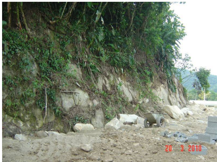
Foto 9.3.7.3-7: Maciço rochoso exposto em corte lateral de estrada de ligação entre o Aterro Terrestre Ambiental e o Sítio Santa Rita, onde será instalado o acesso viário, para obras, à porção continental do empreendimento. Exposição de rocha sã intercalada com rocha alterada dura, ambas com grau fraturamento elevado, marcado pelas fraturas de alívio do maciço conjugada com a estruturação gnáissica e/ou foliação milonítica de transposição (Zona de Cisalhamento Freires-São Lourenço). Porção continental do Município de Santos.
