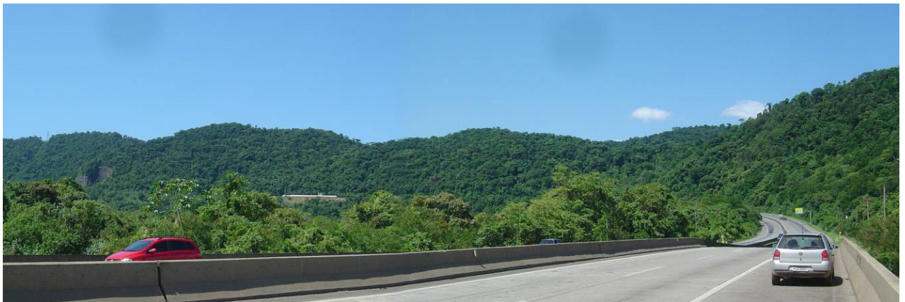
Foto 9.3.4.2-13: Vista da vertente norte da Serra do Quilombo, obtida a partir da ponte sobre o Rio Quilombo. Nesta encosta da Serra são identificadas algumas manchas irregulares de depósitos de tálus e de coluviões que recobrem parcialmente as rochas metamórficas do Complexo Costeiro. Porção continental do Município de Santos.
