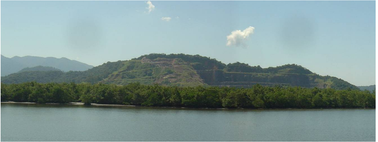
Foto 9.3.4.5-2: Vista do Morro do Gurapá, identificado na margem esquerda do Rio Jurubatuba, a montante do Ramal Ferroviário Conceiçãozinha. Visada para noroeste. No morro, com a Intervals Minérios em atividade, ocorre a unidade granito-gnáissica migmatítica (NPccgm) do Complexo Costeiro. Porção continental do Município de Santos.
