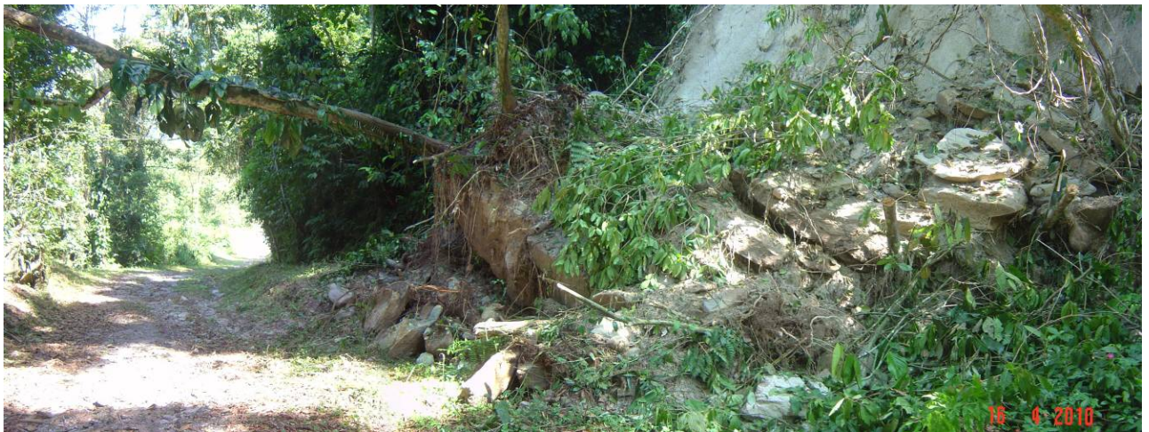
Foto 9.3.4.5-18: Detalhe de escorregamento recente registrado na estrada de acesso ao Sítio Santa Rita, implantada na encosta sul da Serra do Quilombo. Nota-se o tombamento de árvores e o deslocamento de blocos de rocha e de volume considerável de solo, reflexo da movimentação atual mais intensa com escorregamentos associados de alguns dos corpos de tálus identificados na Serra do Quilombo. Visada para oeste-sudoeste.
