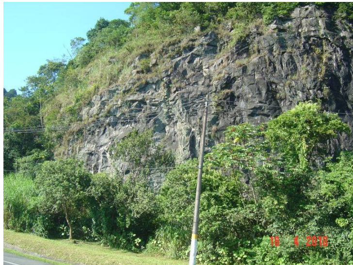
Foto 9.3.7.3-6: Exposição do maciço rochoso da Serra do Quilombo, no local de uma pedreira desativada, às margens da Rodovia Cônego Domênico Rangoni, na AID. Próximo ao topo do maciço, o grau de fraturamento é mais intenso, devido às fraturas de alívio do maciço exposto na abertura da frente de escavação e conjugadas com a estruturação gnáissica e, possivelmente, pela proximidade com a Zona de Cisalhamento Freires-São Lourenço. Porção continental do Município de Santos.
