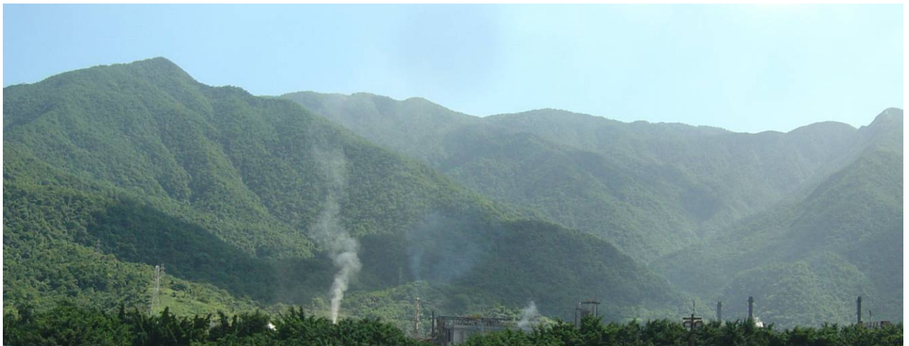
Foto 9.3.7.2-7: Aspecto geral da Unidade Geotécnica 4/3, associada às escarpas da Serra do Mar, onde são reconhecidos terrenos com muito alta suscetibilidade a movimentos de massa (naturais e induzidos) com ocorrência secundária de erosão por ravinas e boçorocas. Vista da Serra de Cubatão a partir da Rodovia Cônego Domênico Rangoni no cruzamento com o Rio Mogi. Visada para norte. Municípios de Cubatão e São Bernardo do Campo.
