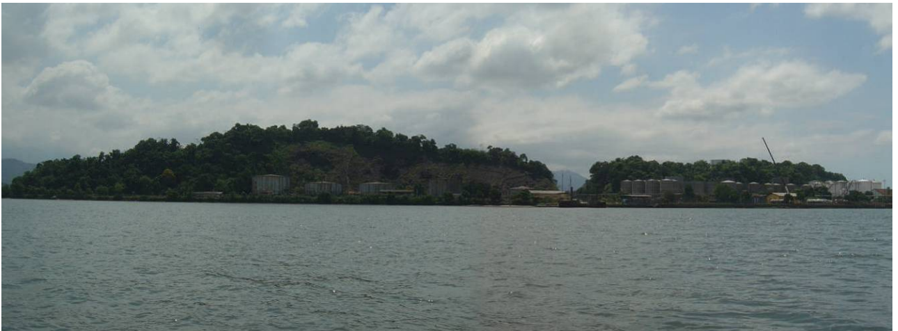
Foto 9.3.4.5-8: Vista dos morros isolados que constituem parte da Ilha Barnabé, instalada na margem esquerda do Canal do Estuário de Santos. Visada para nordeste. Os morros são conformados sobre biotita granitos da fácies Guarujá-Santos (Çay4gs) pertencente à unidade da Rochas Ígneas do Domínio Costeiro. Porção continental do Município de Santos.
