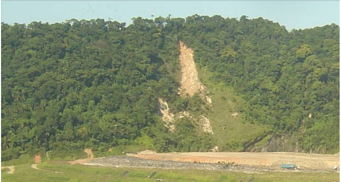
Foto 9.3.7.3-2: Aspecto geral da ocorrência de um escorregamento sobre solos residuais associados com corpos de tálus na vertente sudeste da Serra do Quilombo, na região do Aterro Terrestre Ambiental. Na porção inferior, cicatrizes de escorregamentos, indicando recorrência de processos de instabilidade do corpo de tálus presente na parte inferior da escarpa. Porção continental do Município de Santos, na AID.
