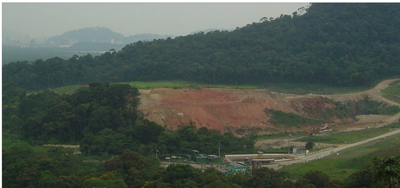
Foto 9.3.7.3-5: Movimentação de terra e corte de morrote na propriedade do Aterro Terrestre Ambiental, com exposição de solos residuais derivados de rochas gnáissicas, que sustentam a Serra do Quilombo e também ocorrem nos limites da ADA. Porção continental do Município de Santos.
