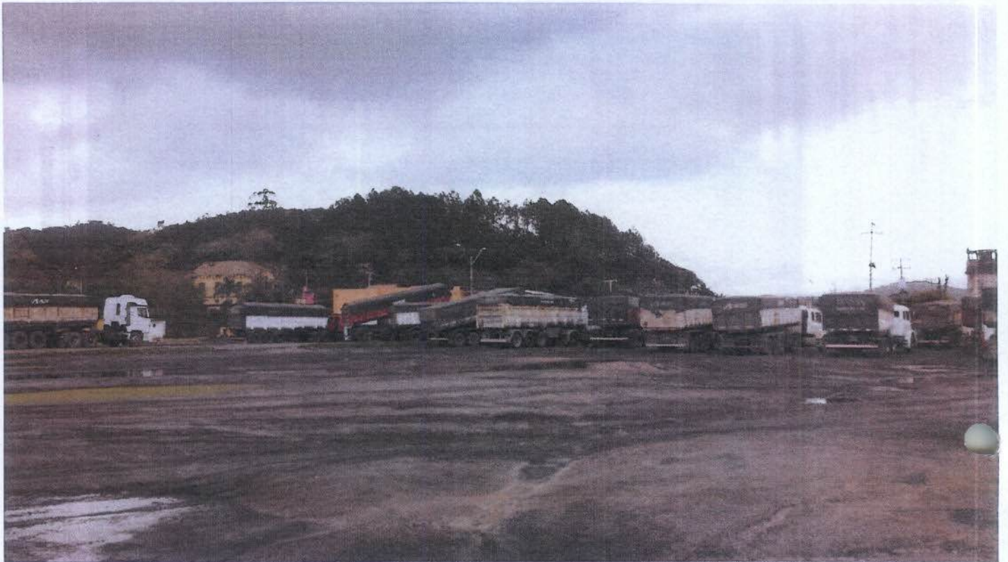
Figura 2: pátio da retroárea do Terminal Barão de Tefé servindo de área de movimentação dos caminhões que transportam as cargas destinadas ao Terminal Portuário Privativo de Ponta do Félix.
