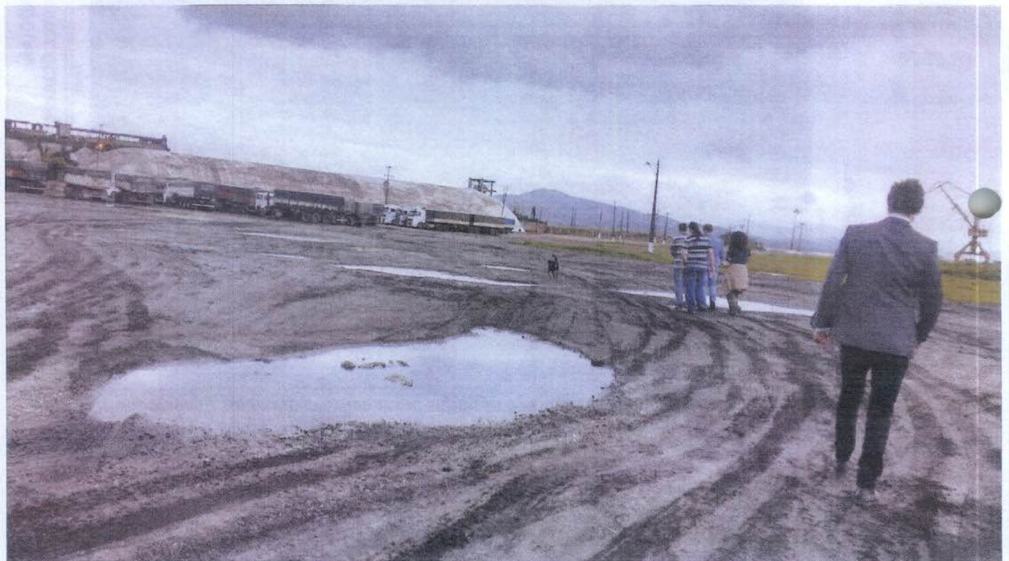
Figura 3: pátio da retroárea do Terminal Barão de Tefé servindo de área de movimentação dos caminhões que transportam as cargas destinadas ao Terminal Portuário Privativo de Ponta do Félix.
