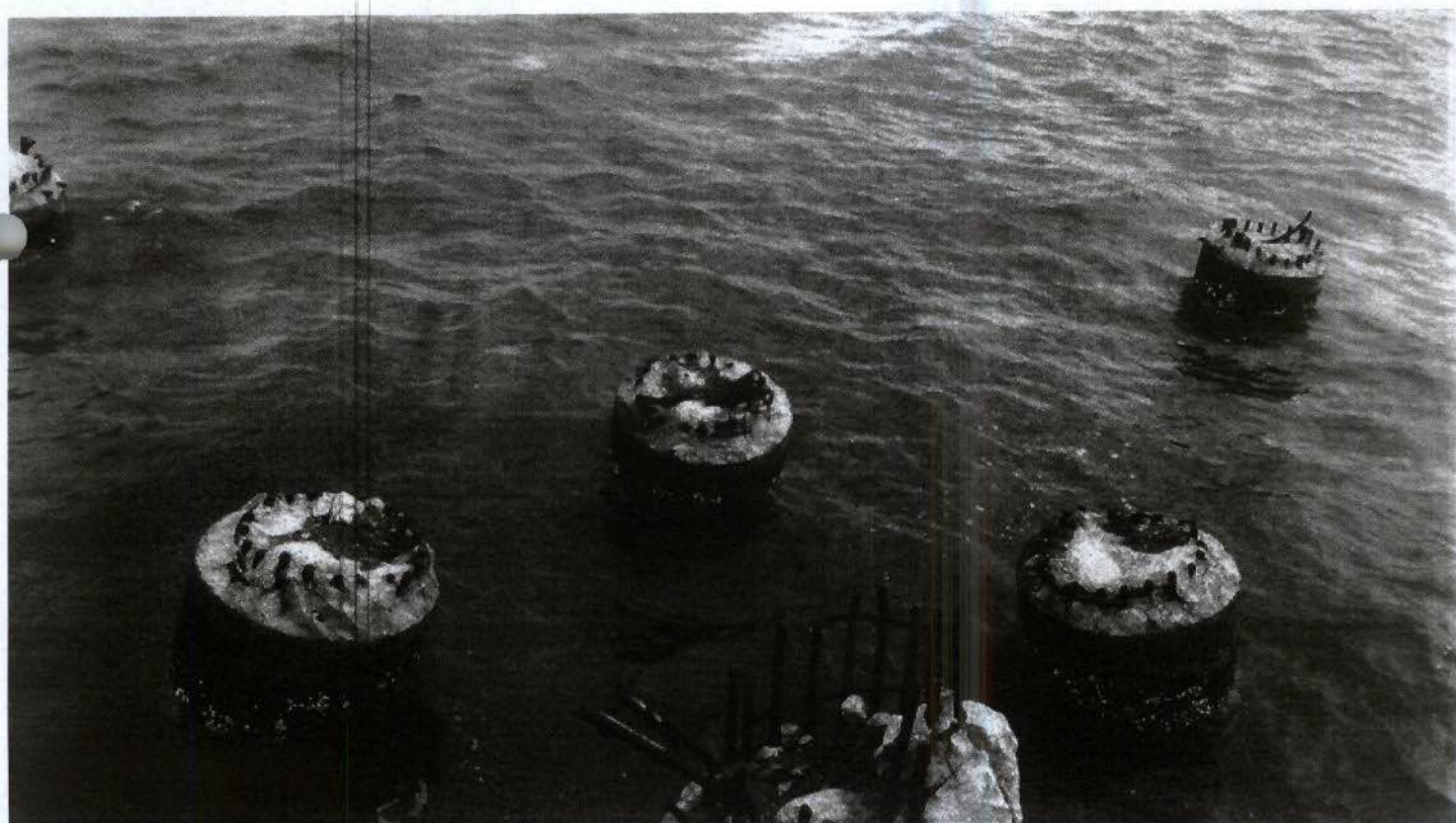
Figura 33: Permanência da fundação de dolphin antigo
