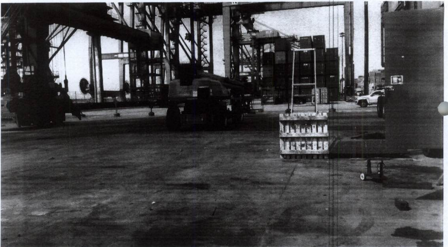
Figura 39: Piso impregnado com óleo.
