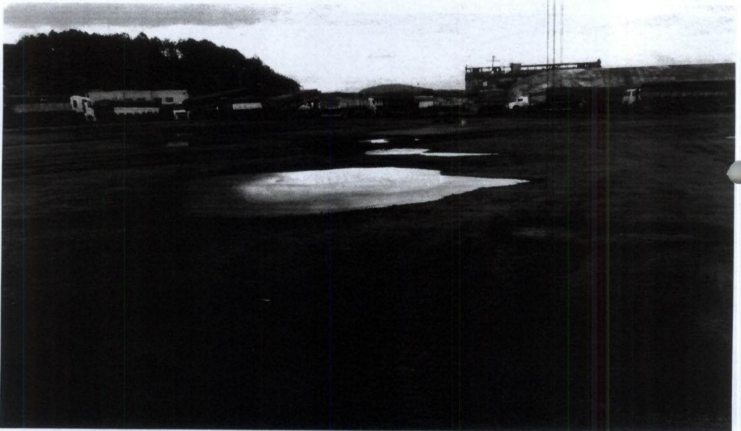
Figura 7: Poças de água de chuva no pátio da retroárea.
