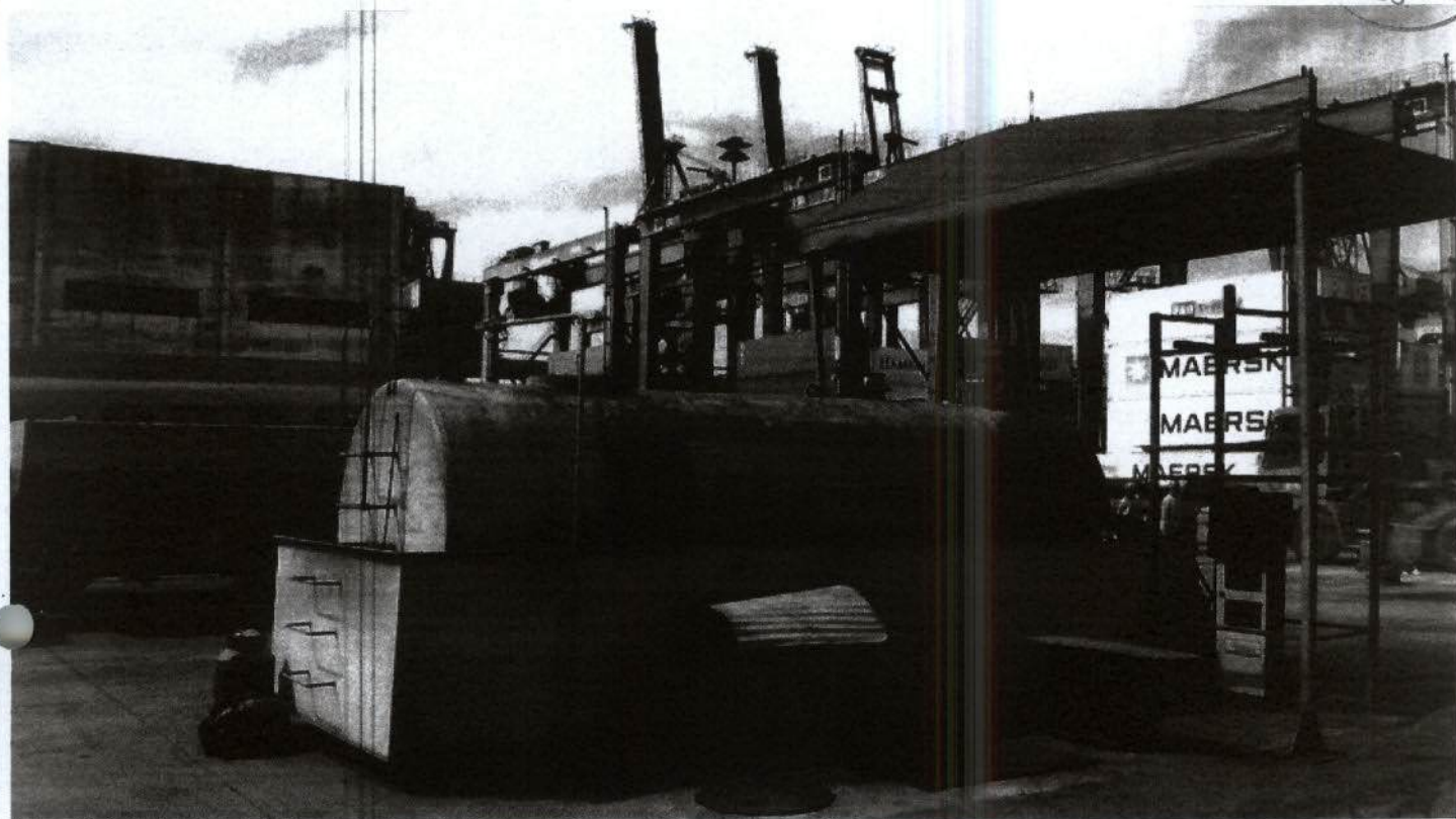
Figura 36: Tanque de armazenamento de óleo.
