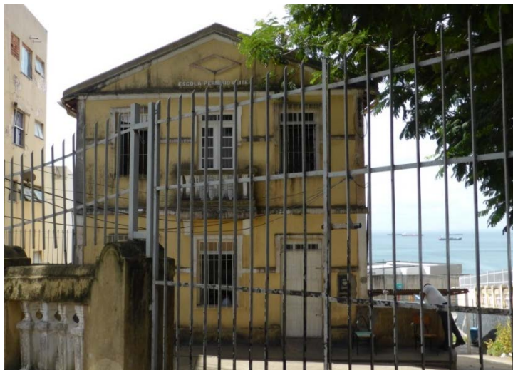
FIGURA 5.3.1-6 – Escola Municipal Perminio Leite. Rua Democrata, Bairro 2 de Julho.
