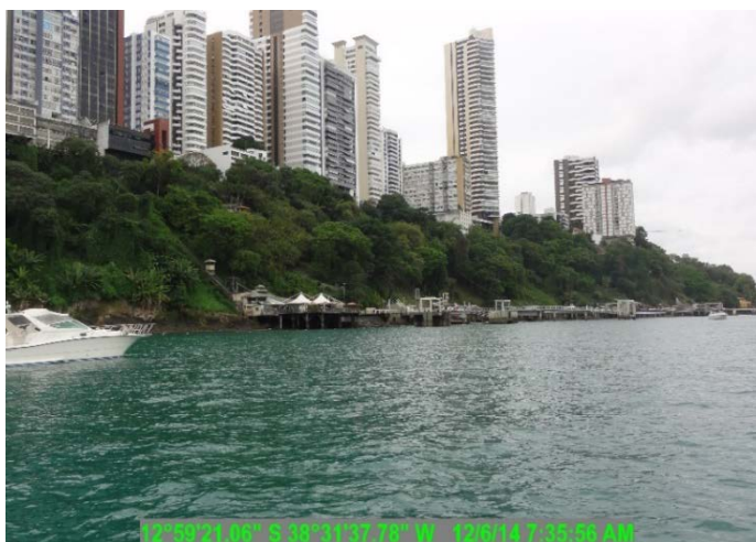
FIGURA 5.3.2-21 – Vista dos píeres instalados na região adjacente ao corredor da vitória.
