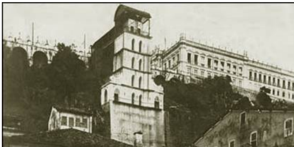
FIGURA 5.3.4-15- Vista do elevador Lacerda do início do século XX 79 .
