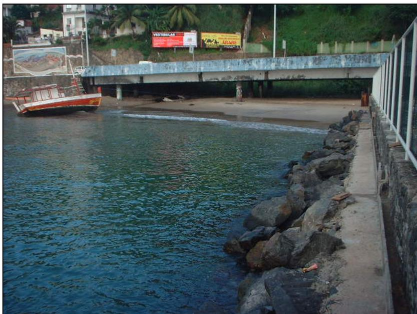
**FIGURA 5.1.2-5- Vista do viaduto da Av. Contorno onde encontram-se acumulados sedimentos erodidos da face da praia da Preguiça.**
