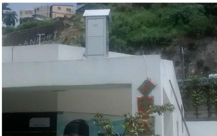
**FIGURA 5.1.5-4 – Hi-Vol instalado no Ponto 2 (oficina da Yamaha).**
