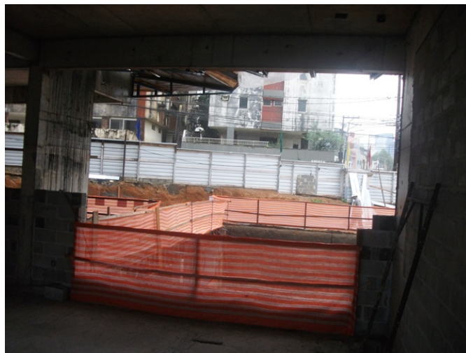
FIGURA 2.3-61 – Guarda corpo (sistema com peças de madeira).
