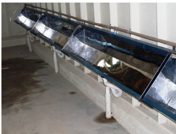
FIGURA 2.3-35– Mictório tipo calha.
