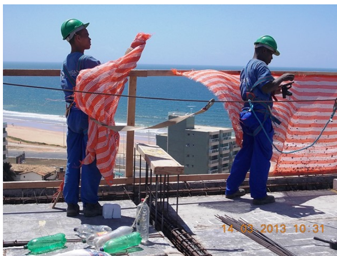
FIGURA 2.3-45– Proteção de vergalhões (1).
