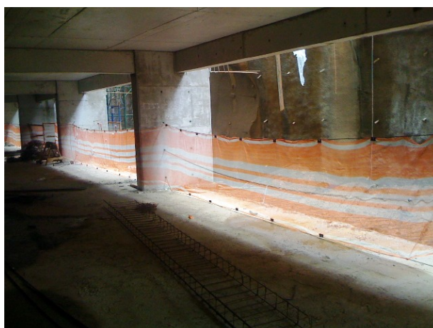
FIGURA 2.3-59 – Guarda corpo (sistema com cabo de aço).
