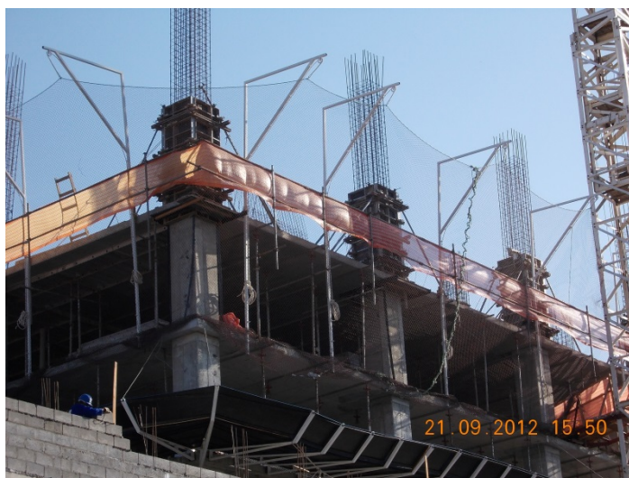
FIGURA 2.3-56– Sistema Limitador de Quedas de Altura (1).
