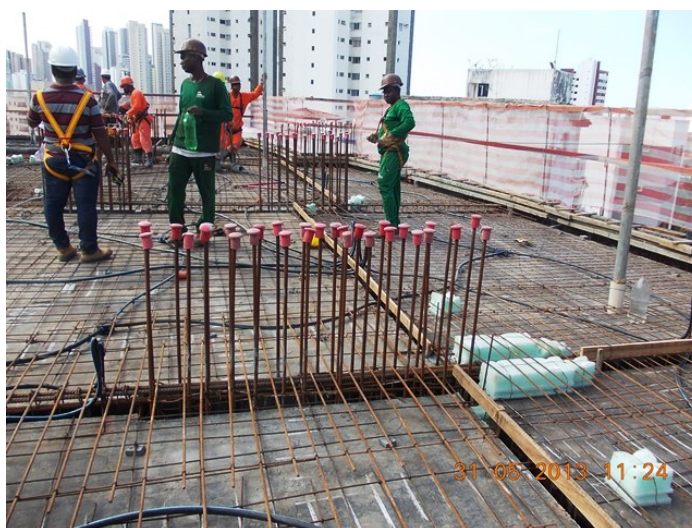
FIGURA 2.3-46– Proteção de vergalhões (2).
