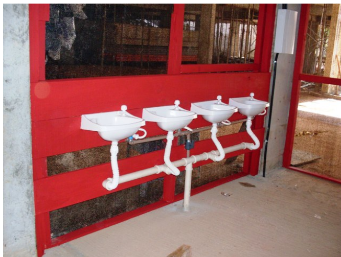
FIGURA 2.3-40– Lavatório no refeitório.
