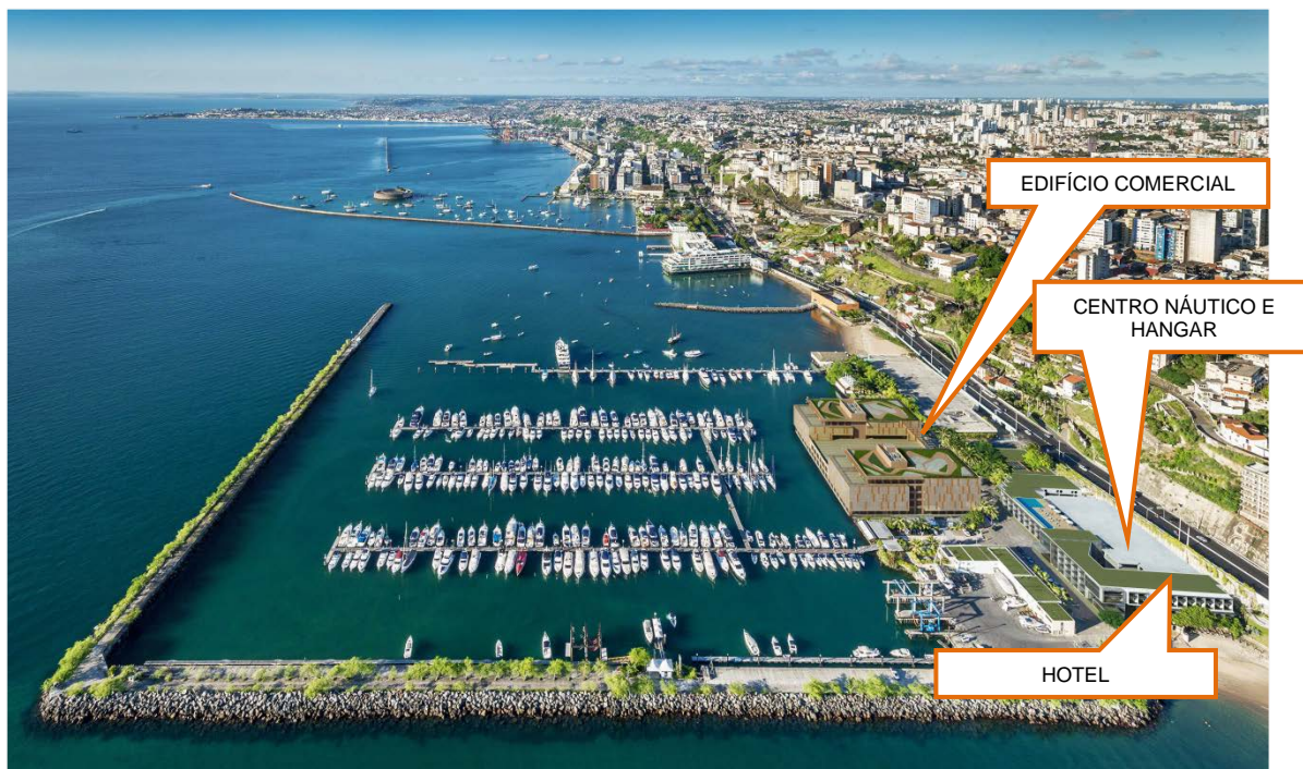
FIGURA 2.3-1– Local de Intervenção das Obras.
