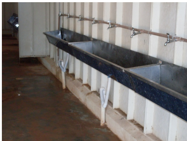
FIGURA 2.3-34– Lavatório tipo calha.
