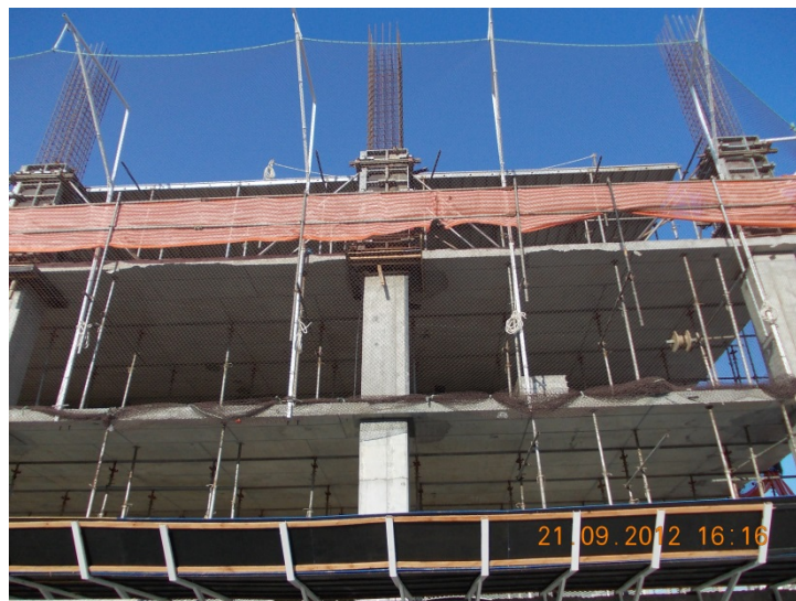
FIGURA 2.3-57– Sistema Limitador de Quedas de Altura (2).
