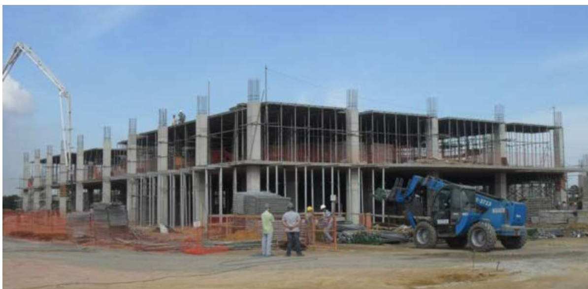
FIGURA 2.3-27 – Estrutura com lajes planas e escoramento metálico.
