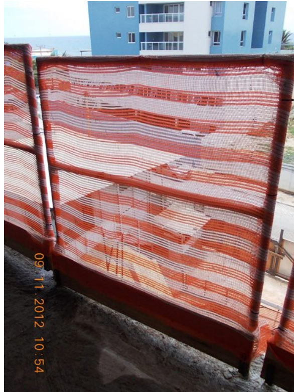
FIGURA 2.3-60 – Guarda corpo (sistema com tubos de aço).
