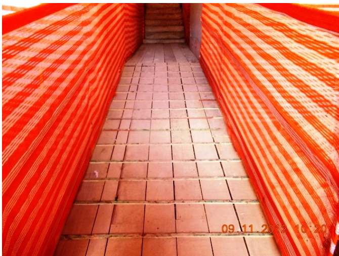
FIGURA 2.3-54 – Rampa de acesso.
