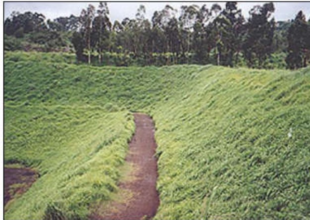
Figura 43 - Exemplo de revestimento de taludes com gramíneas. Fonte: Norma DNIT 074/2006 – ES.
