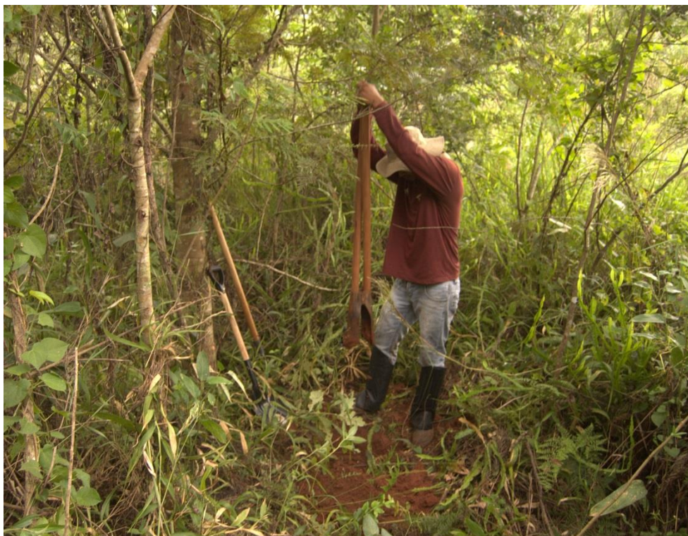
Figura 8 - Abertura de tradagem por um ajudante de campo.
