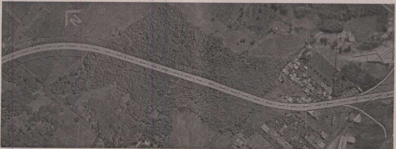
FIGURA 9 – Trecho de acesso à ponte onde inicialmente se previu a interferência do empreendimento em fragmento de vegetação em estágio intermediário de crescimento.
