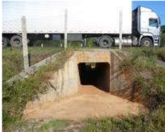
Figura 61. Modelo de passagem de fauna com estrutura de bueiro celular de 2m x 2m acompanhada de cerca-guia.
