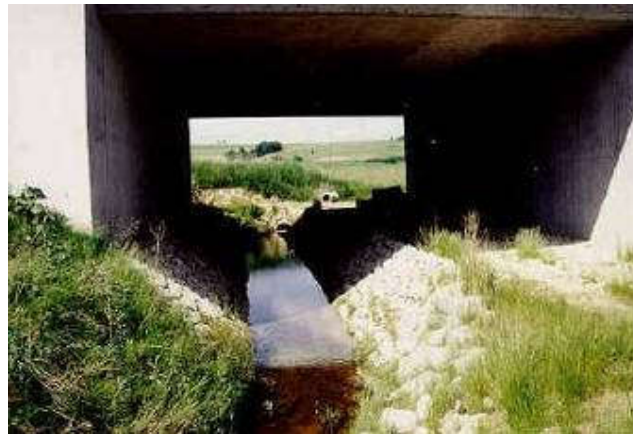
Figura 58. Passagem mista. Fonte: NCHRP.
