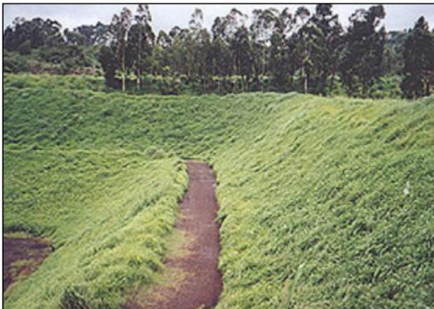
Figura 37 - Exemplo de revestimento de taludes com gramíneas.
