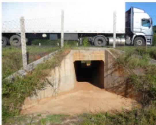
**Figura 31. Modelo de passagem de fauna com estrutura de bueiro celular de 2m x 2m acompanhada de cerca-guia.**
