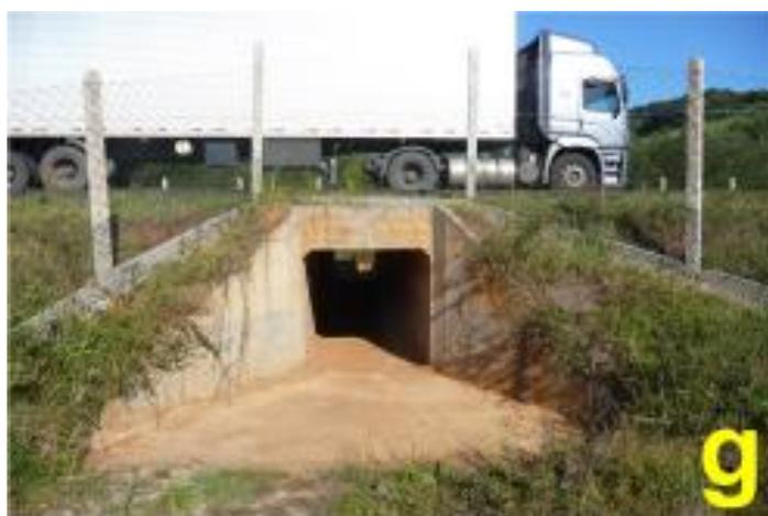
**Figura 9. Modelo de passagem de fauna com estrutura de bueiro celular de 2m x 2m acompanhada de cerca-guia.**
