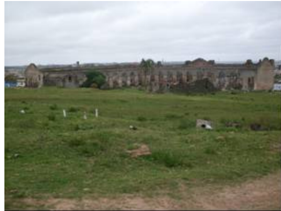
Figura 10. Ruínas da enfermaria
