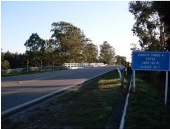
Figura 60 Viaduto da RFFSA, BR – 116, onde se iniciará o empreendimento.
