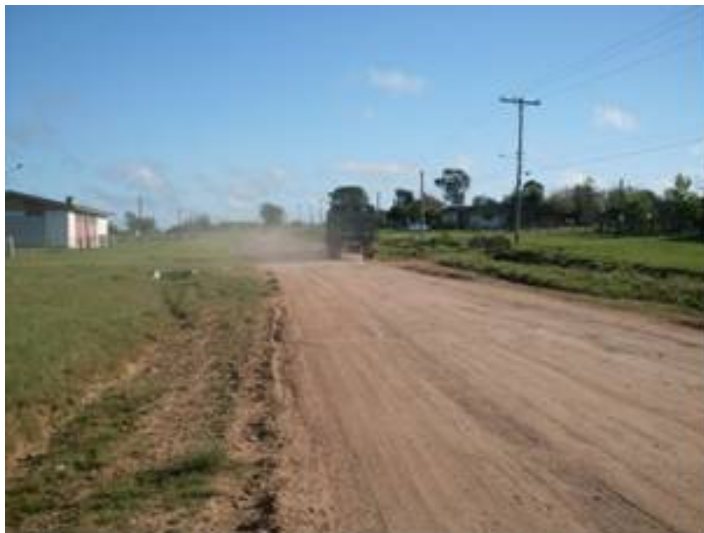
Figura 88. Via de acesso ao Serro do Matadouro. UTM 22 L 276883/6398174
