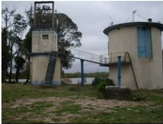
Figura 57. Captação de água no Rio Jaguarão, a jusante do local previsto para a nova ponte.
