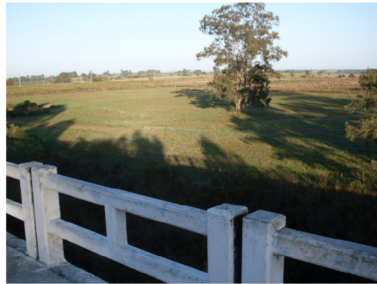
Figura 61 Vista do trecho comum, a partir do viaduto da RFFSA, na BR 116, sentido Jaguarão
