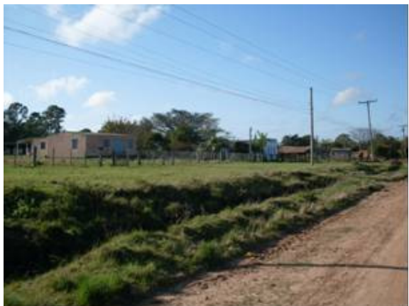
Figura 51 Canal para escoamento de esgoto e águas pluviais – Cerro do Matadouro
