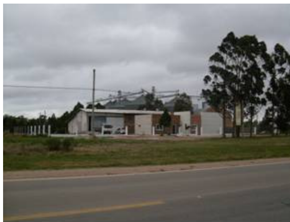
Figura 77. Armazém graneleiro em Jaguarão.
