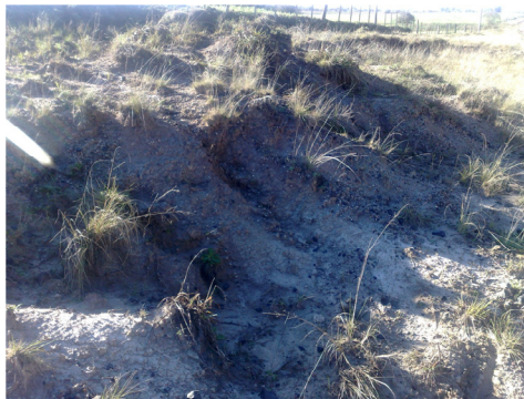
Figura 47. início de processo erosivo.
