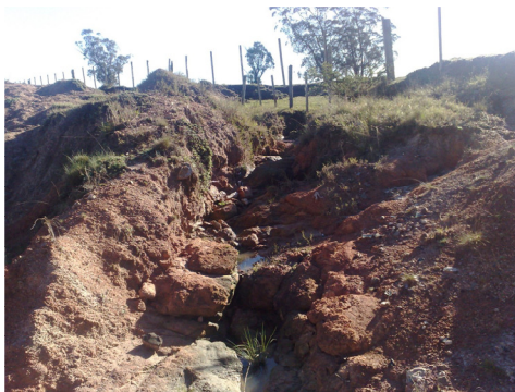
Figura 48. processo erosivo em desenvolvimento.
