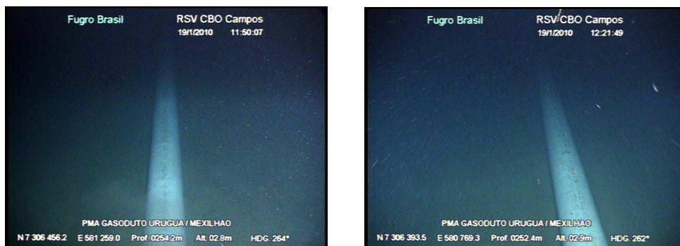
Figura IV. 4 - Imagens do fundo próximas ao duto e seu entorno após o seu lançamento.
