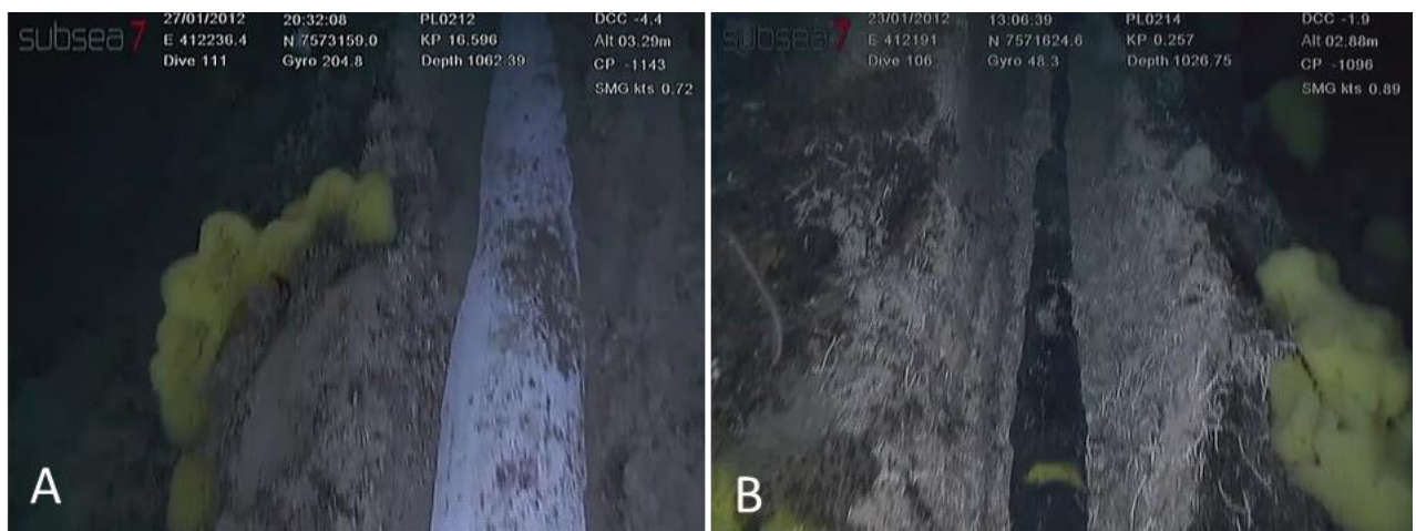
Figura 5. Exemplos de trincheiras formadas pelos dutos em contato com os bancos. Notar a presença de esponjas vivas (em amarelo) nas proximidades da região diretamente impactada pelo contato direto do duto durante a instalação. A) Duto da P-52; B) Duto da P-54. Notar a presença de corais, esponjas e equinodermos vivos nas proximidades do duto.
