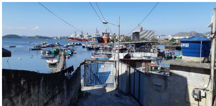
Figura II.3.3.1.3.22-6 – O cais do Chatão é uma das estruturas de apoio à pesca artesanal na Ilha da Conceição.
