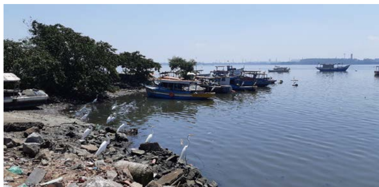
Figura II.3.3.1.1.23-1 – Vista parcial do porto de Ramos - Rio de Janeiro
