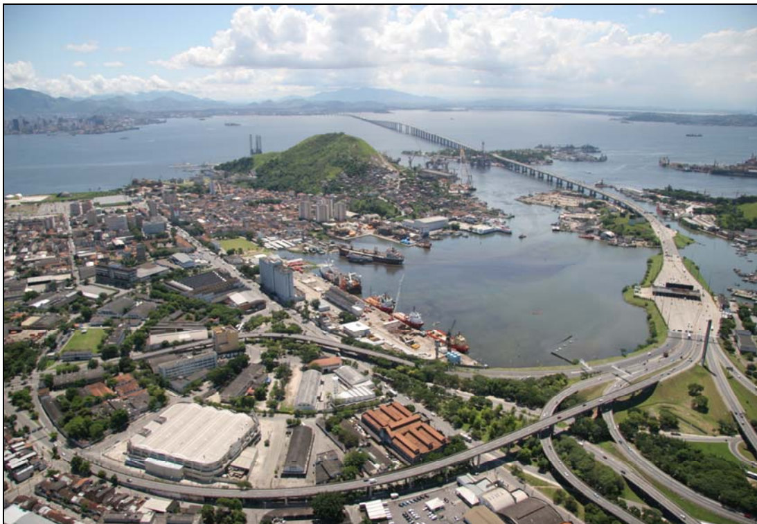
Figura III-2 - Vista aérea dos Terminais Marítimos Nitshore.
