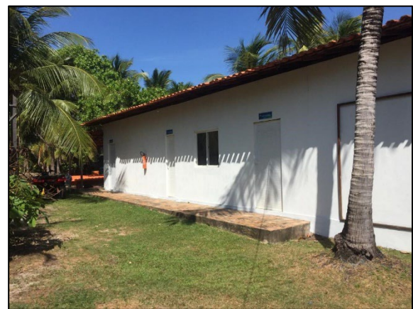
Figura II.10.4-5 - Visão lateral da área de externa setor destinado ao atendimento aos animais no Instituto Amares.
