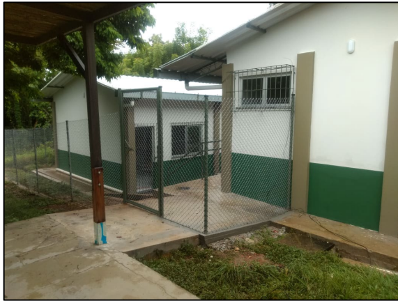
Figura II.10.4-12 - Área externa do setor destinado ao atendimento aos animais da Universidade Federal Rural do Amazonas UFRA.
