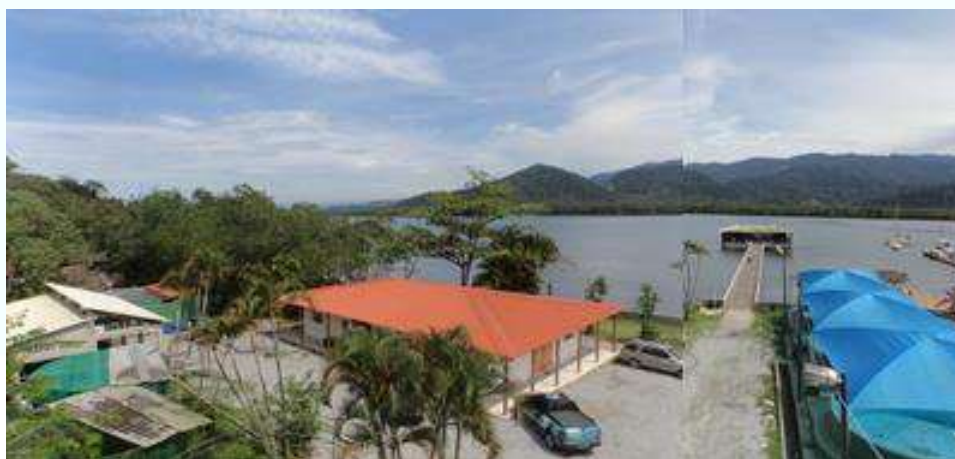
FIGURA 1: Vista do CETAS-Guarujá.
