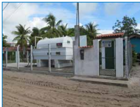
Foto 4.3-31 - Base para abastecimento de combustível.
