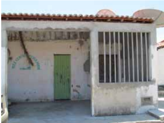
Foto 4.3-91 - Fachada do Tele Centro Pesca Maré, na localidade de Saramém (município de Brejo Grande).
