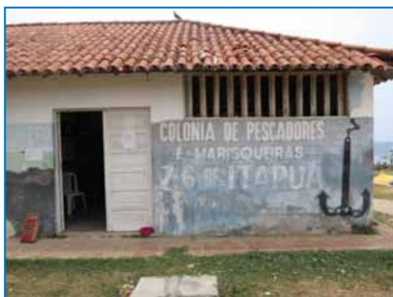
Foto 4.3-74 - Vista da Colônia Z-06 da comunidade de Itapuã.
