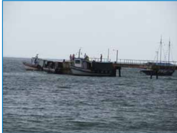
Foto 4.3-19 - Píer em Barra Grande, no município de Maraú/BA.
