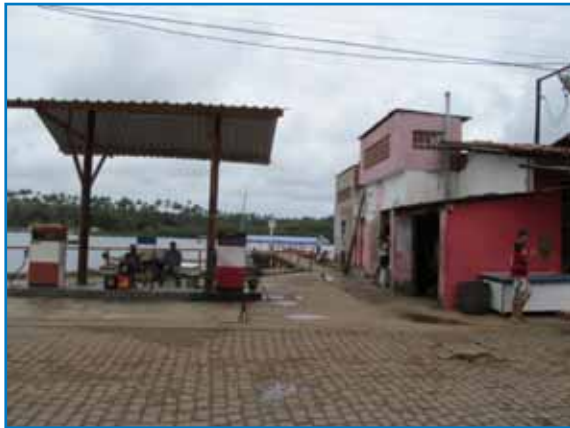
Foto 4.3-22 - Posto de Abastecimento em Camamu/BA.
