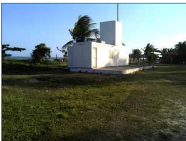
Foto 4.3-103 - Fábrica de gelo da Colônia Z-21, desativada devido ao alto custo de manutenção.
