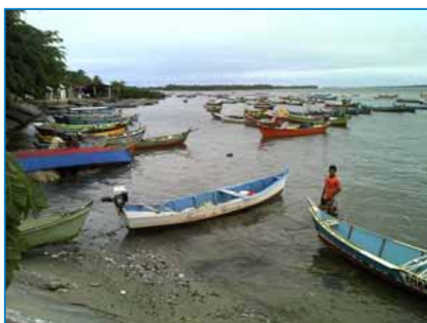
Foto 4.3-94 - Encostado de concreto no centro de Piaçabuçu, rio São Francisco.
