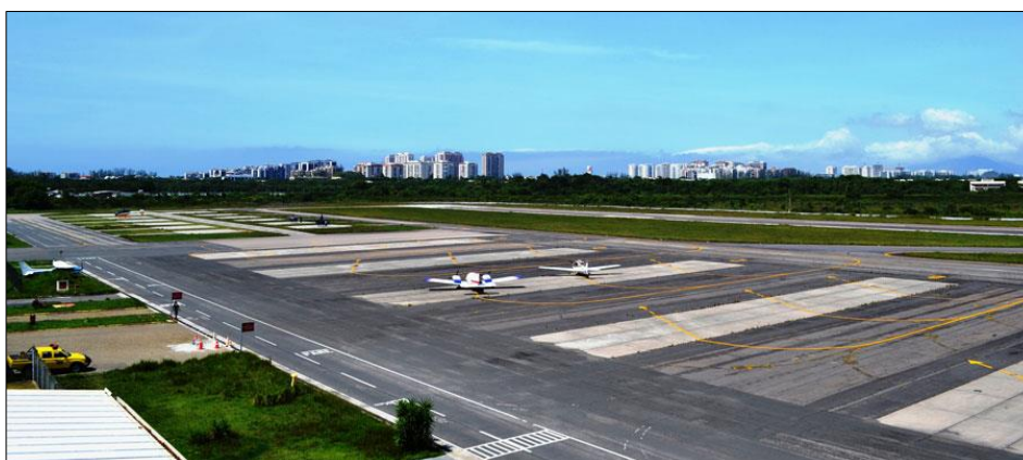
Figura II.5.3-4 - Pista de taxiamento do Aeroporto de Jacarepaguá. Fonte: Infraero Aeroportos (2018) 7 .
