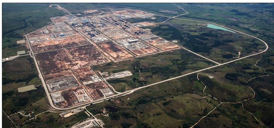
Figura II.5.3-6 - Polo GasLub Itaboraí. Fonte: Petrobras (2021b).
