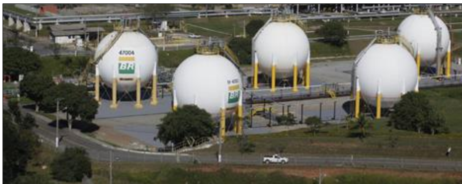
Figura II.5.3-5 - Terminal de Cabiúnas.
