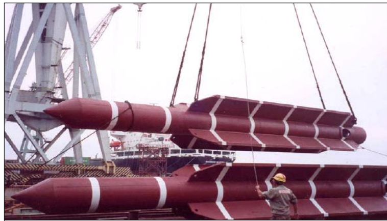
Figura II.2.4.5.1.10-2 – Estaca do tipo torpedo utilizada em ancoragem.
