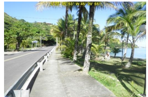
Acesso à Praia dos Barreiros
