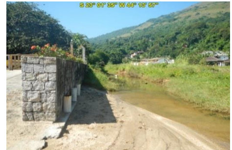
Acesso à Praia da Tartaruga
