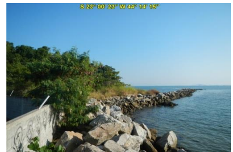
Enrocamento no canal na Praia Jacuecanga
