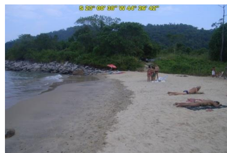
Enrocamento na Praia do Laboratório
