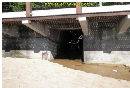
Arroio na Praia Grande
