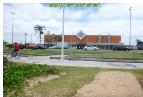
Acesso à Praia da Tartaruga
