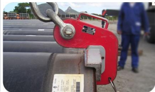
Figura 11 – Instalação da patola no duto
