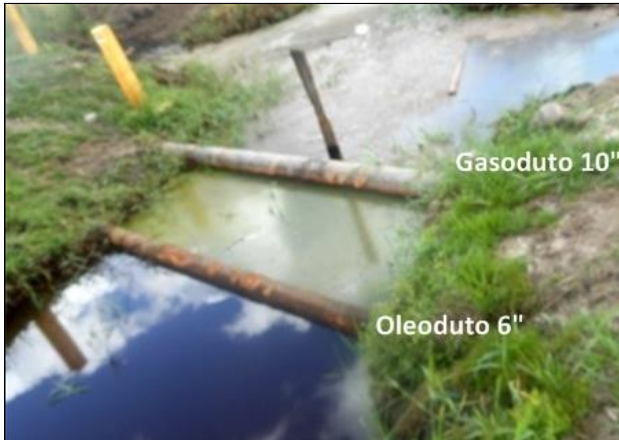
Figura 6 – Trecho aéreo do oleoduto de 6" a 2,5 km da Estação de Fazenda Cedro
