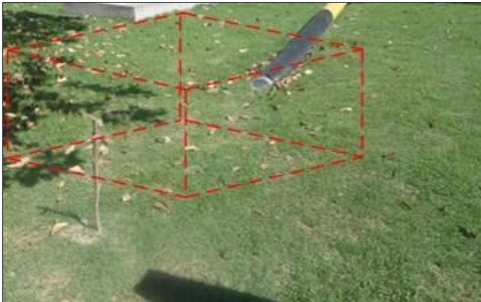
Figura 4 – Local de escavação para seccionamento do gasoduto de 10” na Estação de Fazenda Cedro
