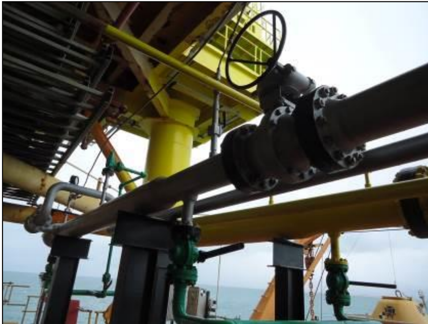
Figura 3 – Lançador de pig do oleoduto de 6”
