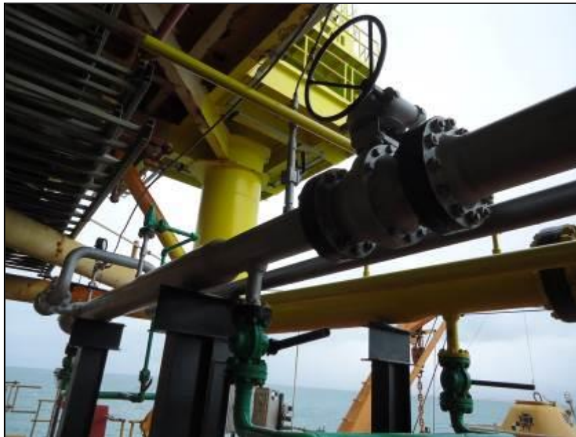
Figura 3 – Lançador de pig do oleoduto de 6"
