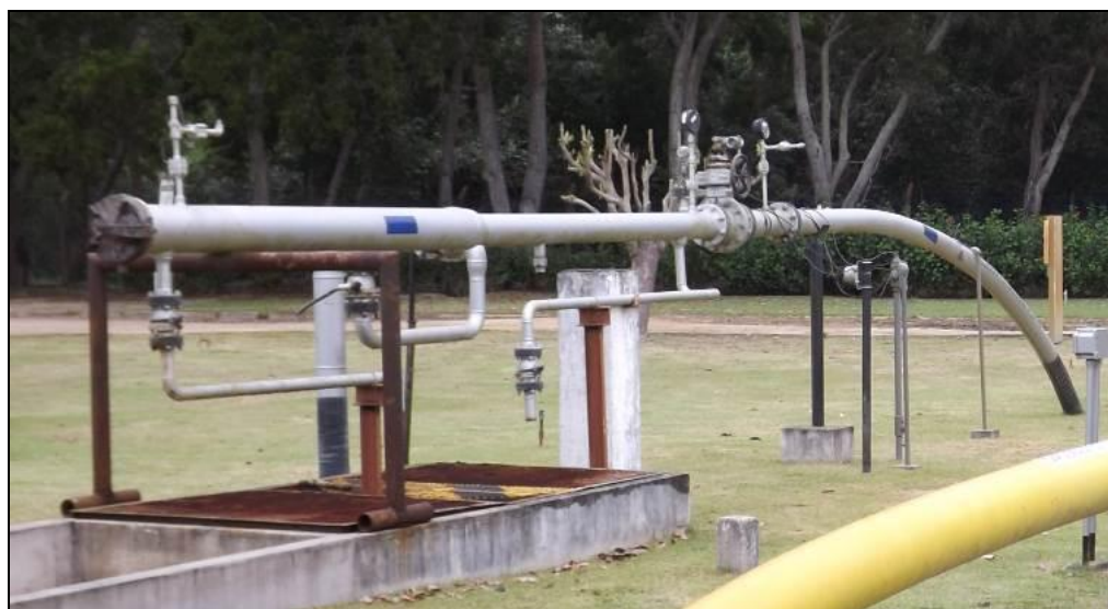
Figura VI.3-2 - Recebedor de pig do oleoduto de 6"
