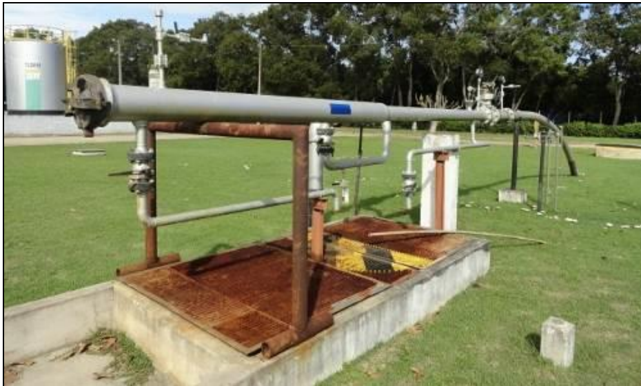
Figura 1 – Recebedor de pig do oleoduto de 6" em FC
