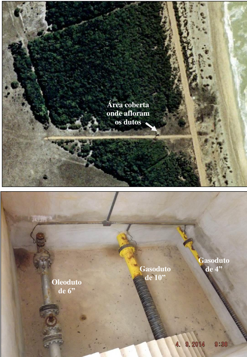
Figura 6 – Ponto de afloramento dos dutos na praia de Urussuquara
