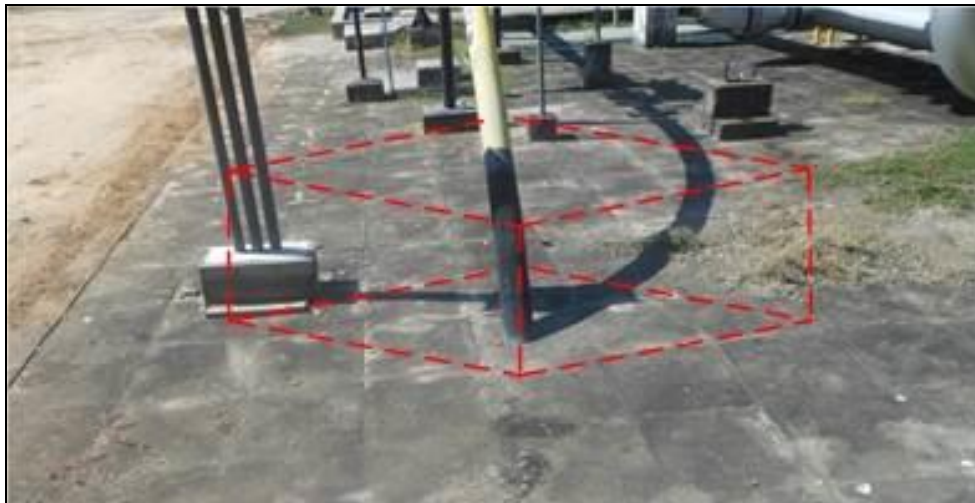
Figura 6 – Local de escavação para seccionamento do gasoduto de 4" na Estação de Fazenda Cedro
